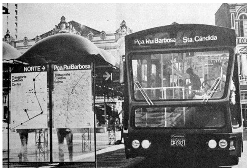
Figura 5 - Integração dos corredores de transporte da cidade de Curitiba
