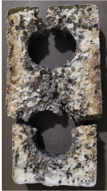
Figura 11 - Bloco compósito com furos demonstrando falhas em sua estrutura
