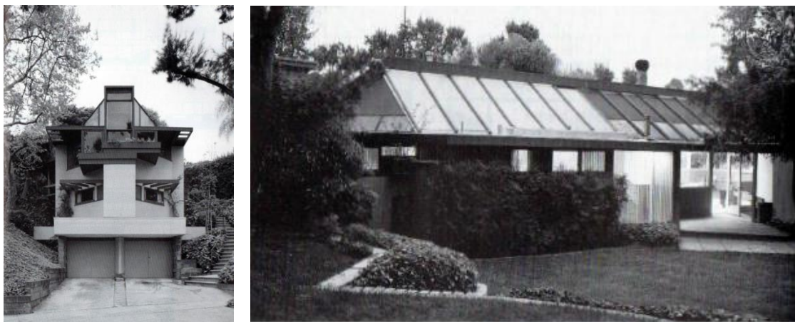
Figuras 63-64: Exteriores da Casa Tischler (1949-1950), Westwood, R. M. Schindler. Fonte: Sheine (1998, p.216-221).
