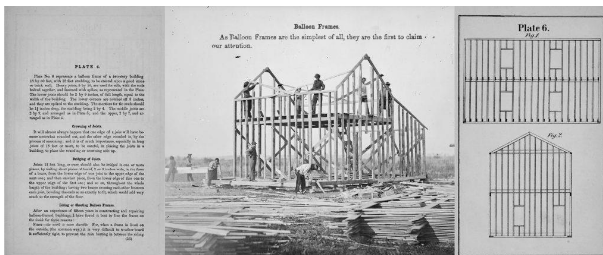
Figura 62: Fotografia de homens construindo uma casa com estrutura de Balloon Frame , reserva de Omaha, Nebraska, 1877.
