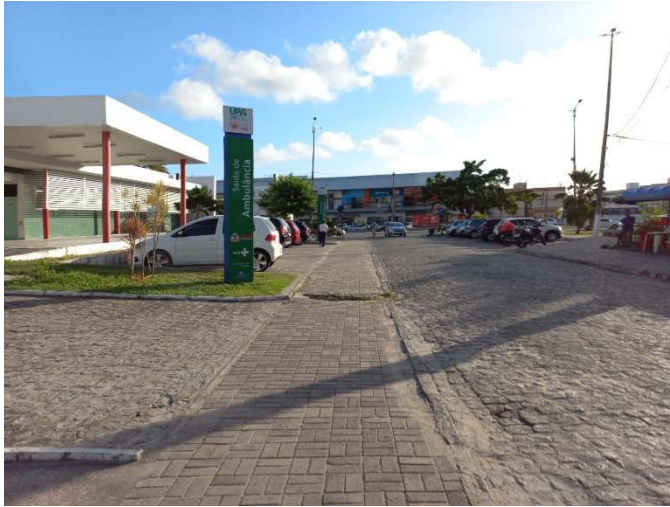
Figura 68: Ausência de sombreamento nos passeios.
