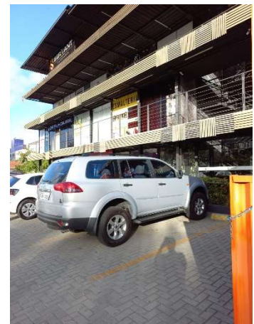
Figura 67: Fachada com vitrines e terraços.
