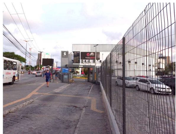
Figura 101: Ausência de sombreamento ao longo do passeio do Shopping Sul.
