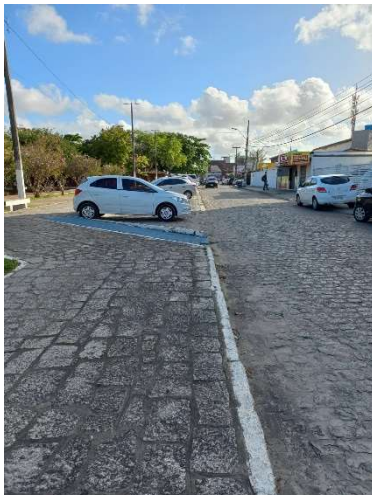
Figura 86: Rampa na praça desconectada de outros elementos de acessibilidade no trecho 3.
