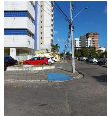
Figura 73: Calçada com rampa sem conexão com rota acessível no trecho 2.
