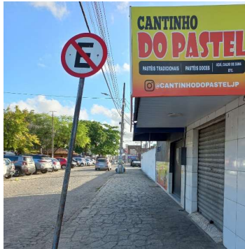
Figura 92: Marquise avançando sobre passeio.
