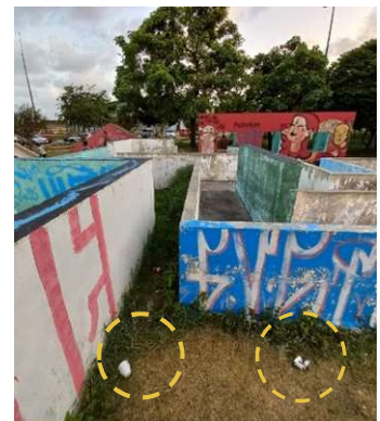
Figura 55: Lixo no chão parquinho.
