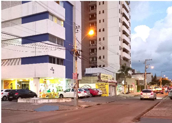
Figura 80: Posteamento, fiação elétrica e ausência de marquises no Trecho 2.
