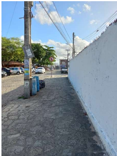
Figura 88: Fachada cega no trecho 3.
