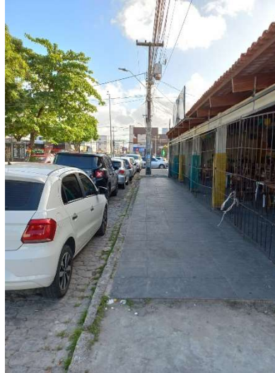
Figura 84: Calçada com desnível no trecho 3.
