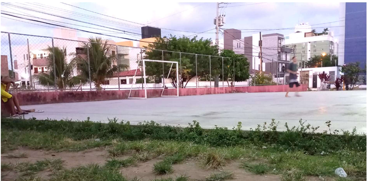
Figura 114: Borda da quadra na qual usuários assistem as partidas de futsal – ausência de arquibancada e de manutenção.
