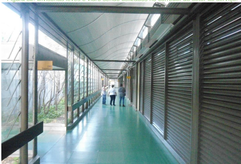
Figura 82: Divisórias leves e vidro sendo utilizados no corredor do setor de serviço.
