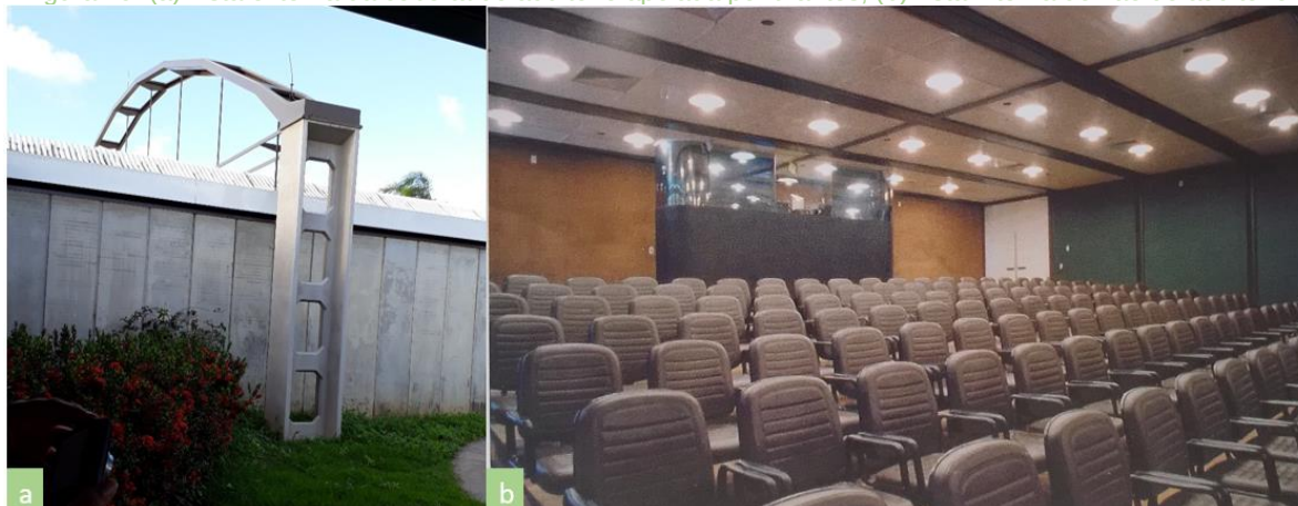
Figura 79: (a) vista externa da coberta do auditório apoiada por tirantes; (b) Vista interna do vão do auditório.
