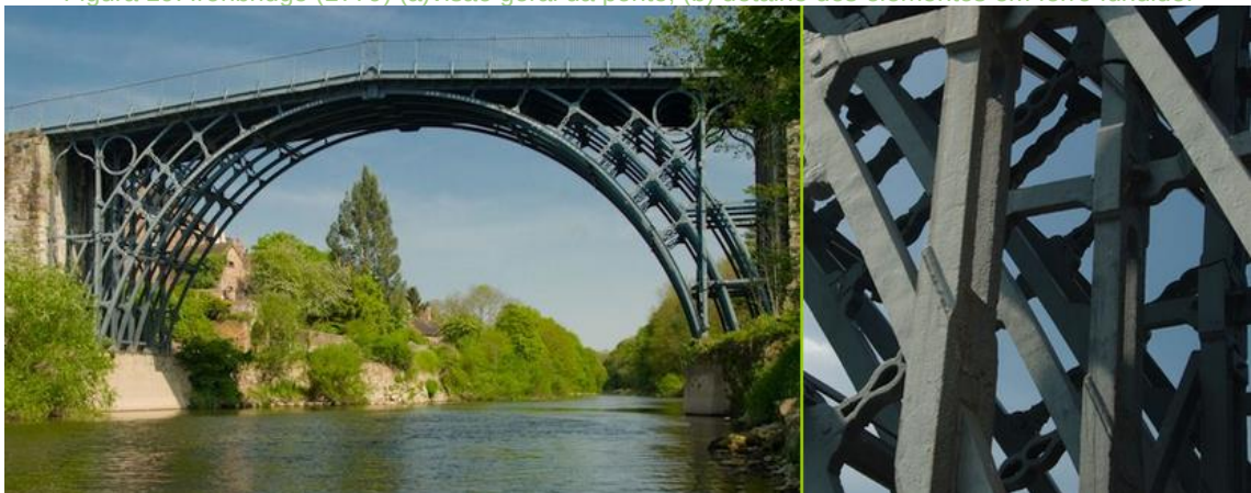
Figura 19: Ironbridge (1779) (a)visão geral da ponte; (b) detalhe dos elementos em ferro fundido.
