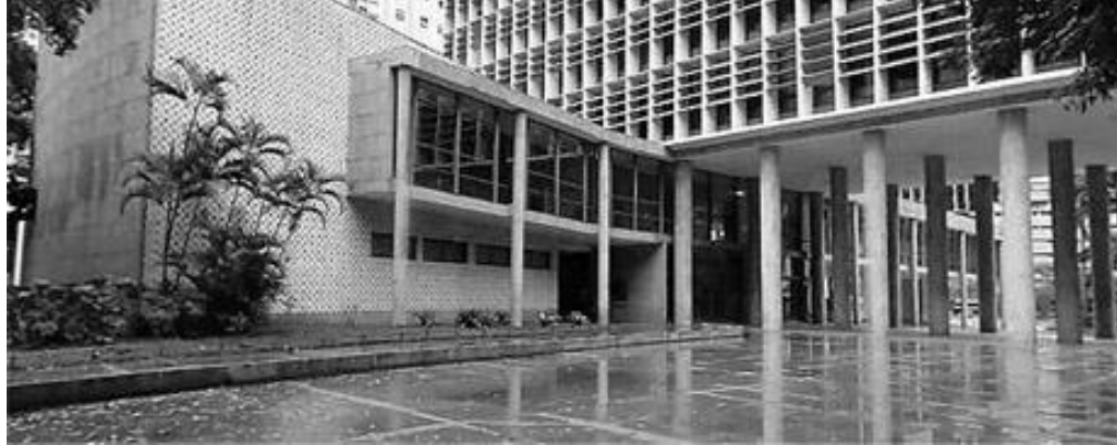
Figura 14: Uso do pilotis para permeabilidade do térreo no Palácio Gustavo Capanema/RJ (1936).
