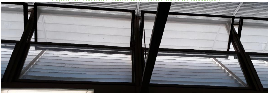
Figura 88: Testeira e brises vistos pelo interior da edificação.
