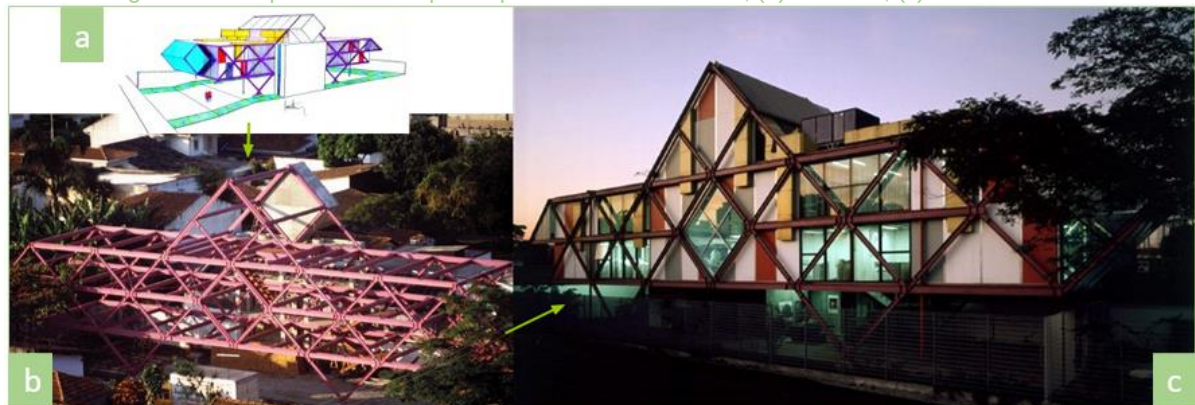
Figura 33: Croqui inicial do arquiteto para sede do escritório; (b) Estrutura; (c) Obra finalizada.
