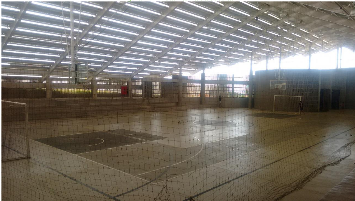
Figura 117: Vista interna da cobertura.
