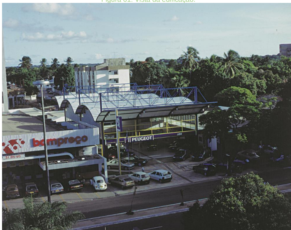
Figura 61: Vista da edificação.
