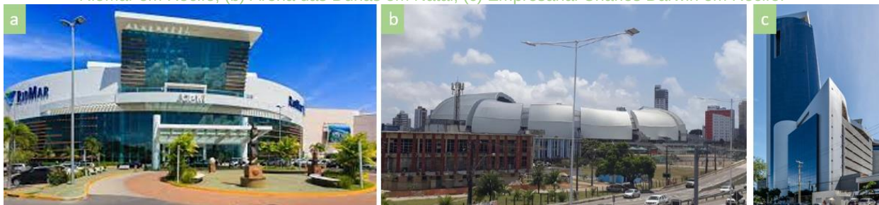
Figura 35:Edificações de estrutura metálica, que, externamente não há legibilidade estrutural. (a) Shopping RioMar em Recife; (b) Arena das Dunas em Natal; (c) Empresarial Charles Darwin em Recife.
