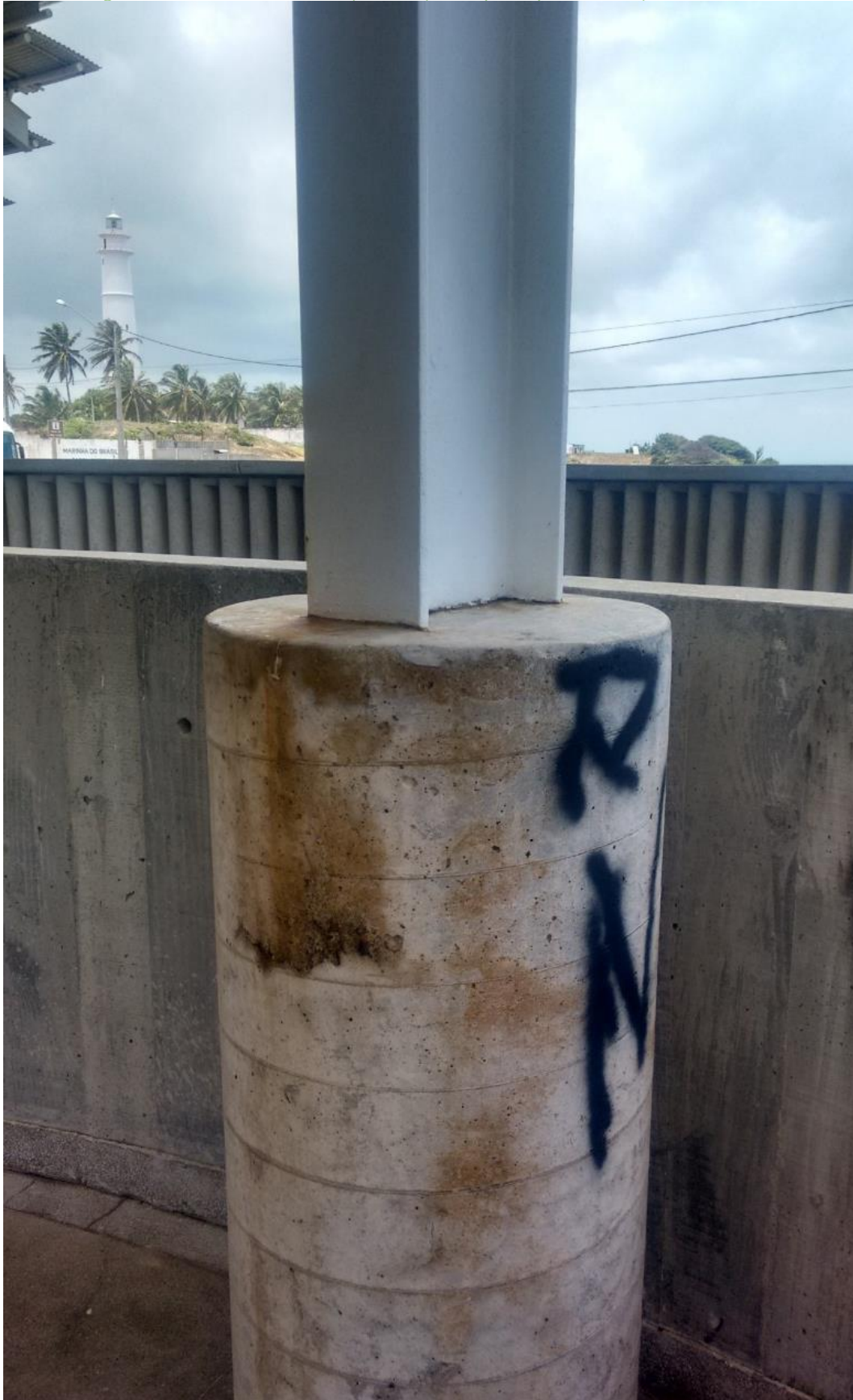
Figura 118: Detalhe da mudança de seção do pilar após a transição de material.
