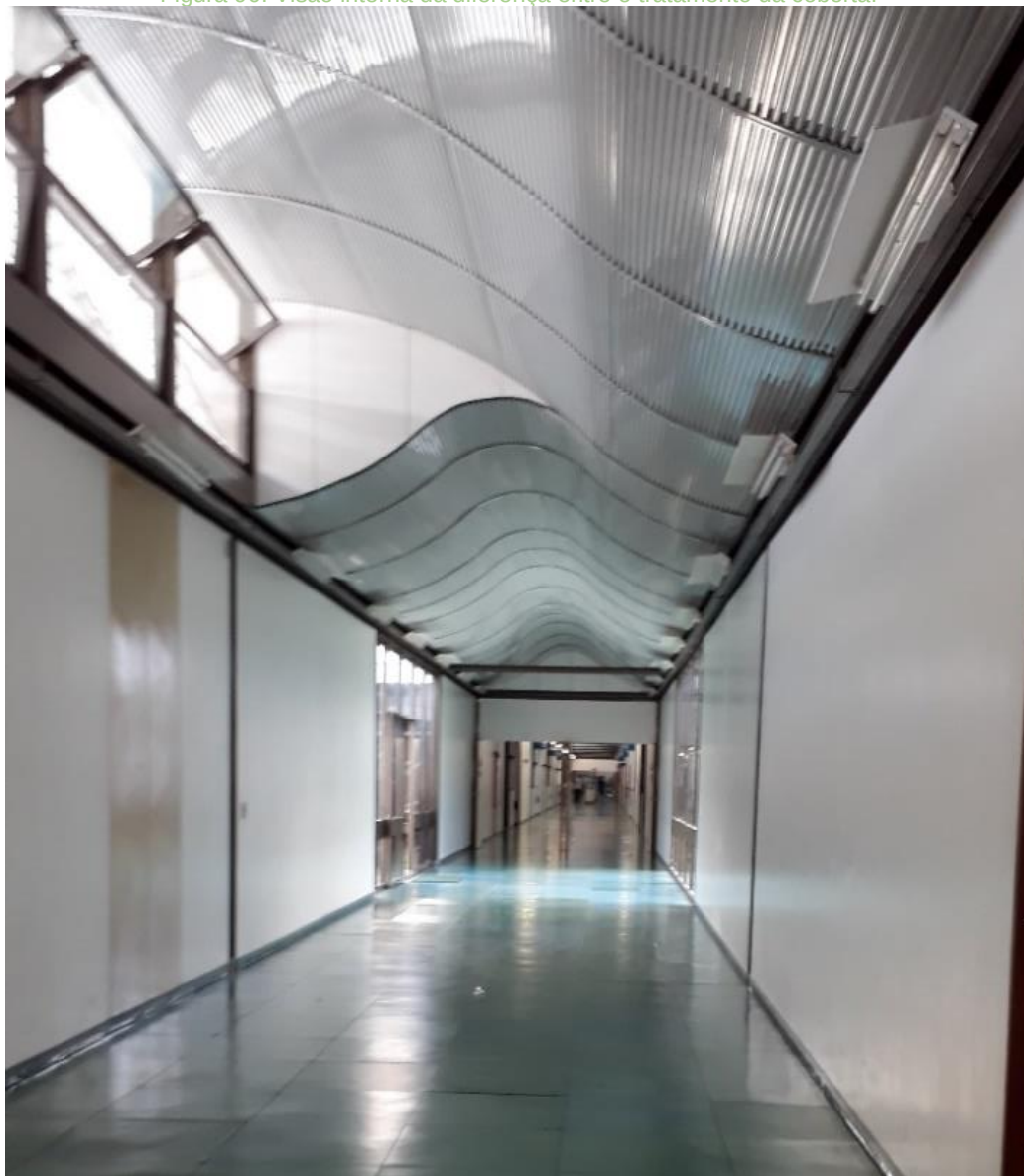
Figura 90: Visão interna da diferença entre o tratamento da cobertura.
