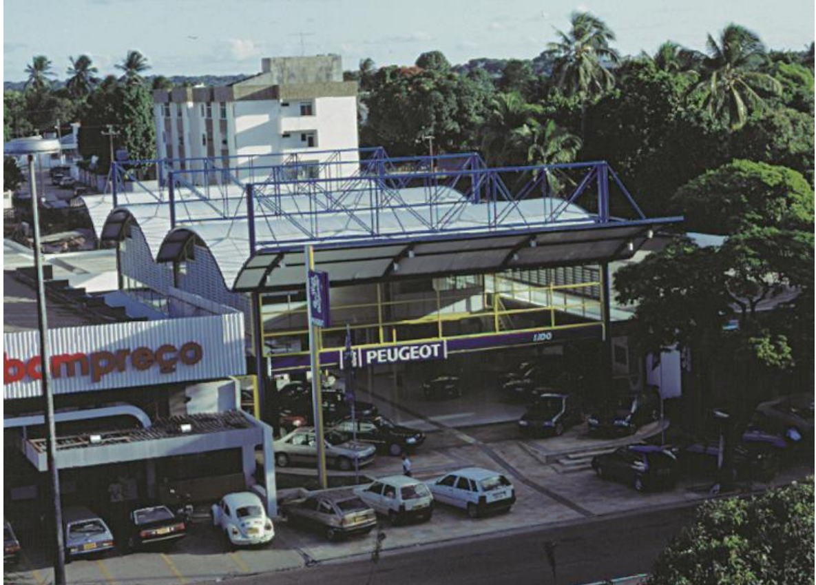
Figura 45: Edificação da Concessionária Peugeot, 1996.
