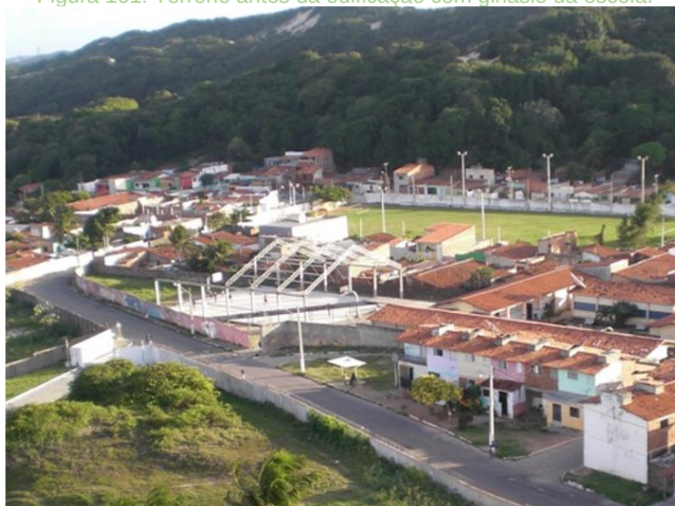
Figura 101: Terreno antes da edificação com ginásio da escola.
