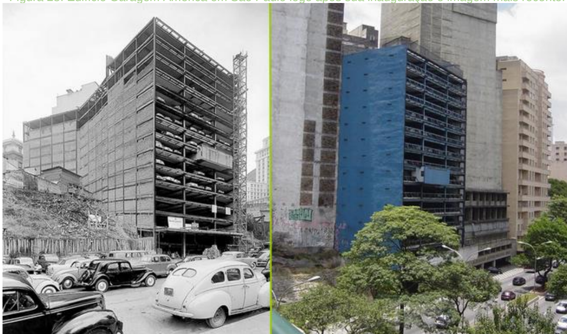
Figura 28: Edifício Garagem América em São Paulo logo após sua inauguração e imagem mais recente.
