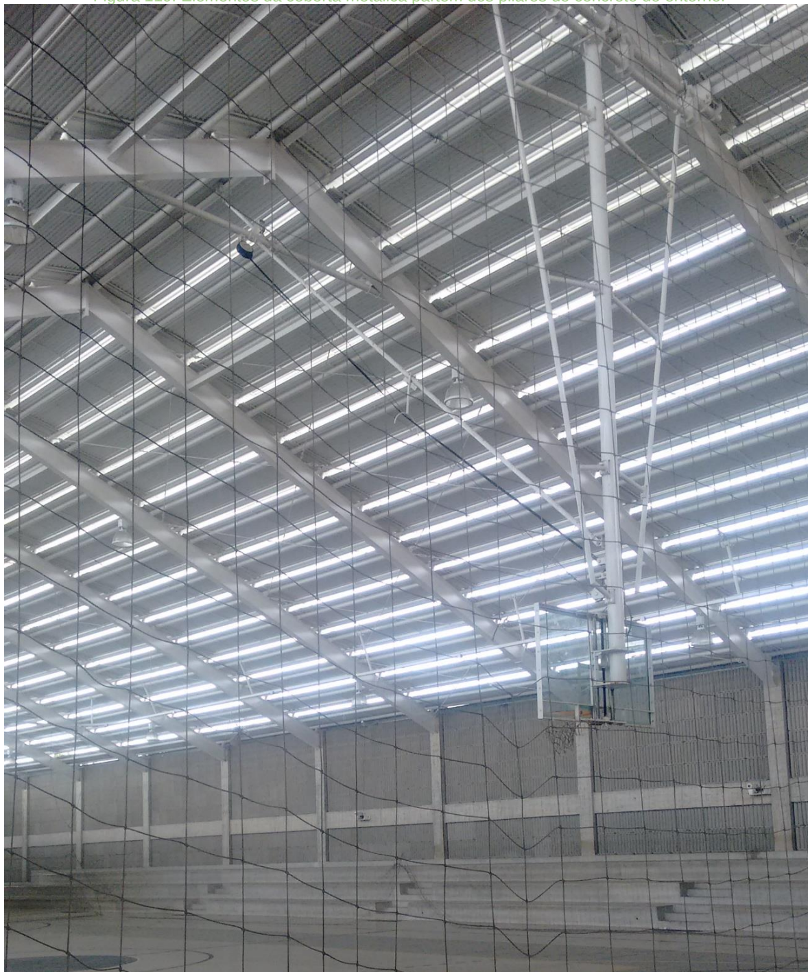
Figura 119: Elementos da cobertura metálica partem dos pilares de concreto do entorno.
