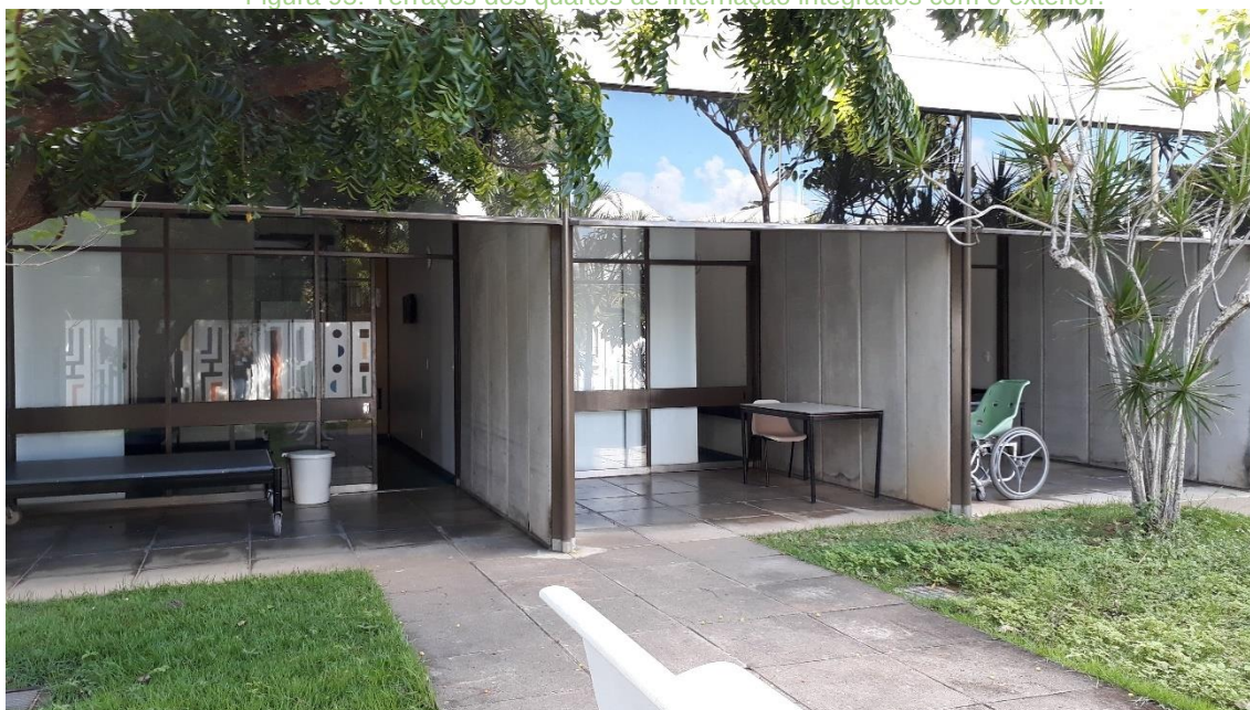
Figura 95: Terracos dos quartos de internação integrados com o exterior.
