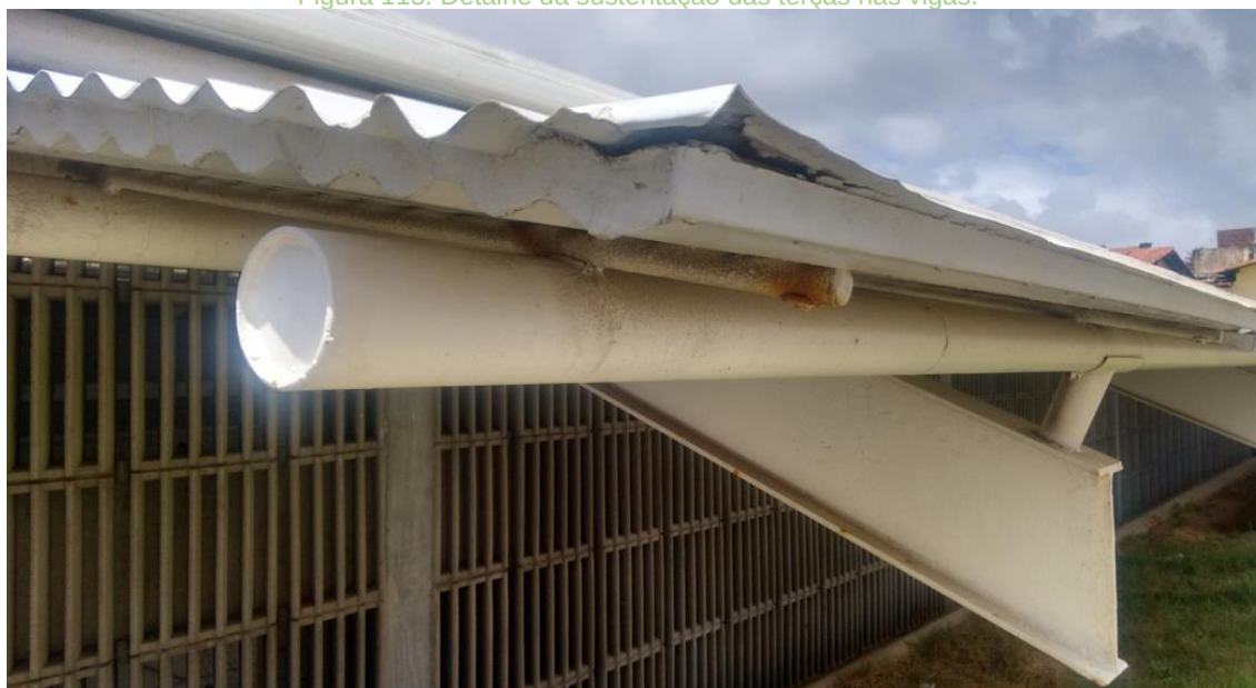
Figura 115: Detalhe da sustentação das terças nas vigas.
