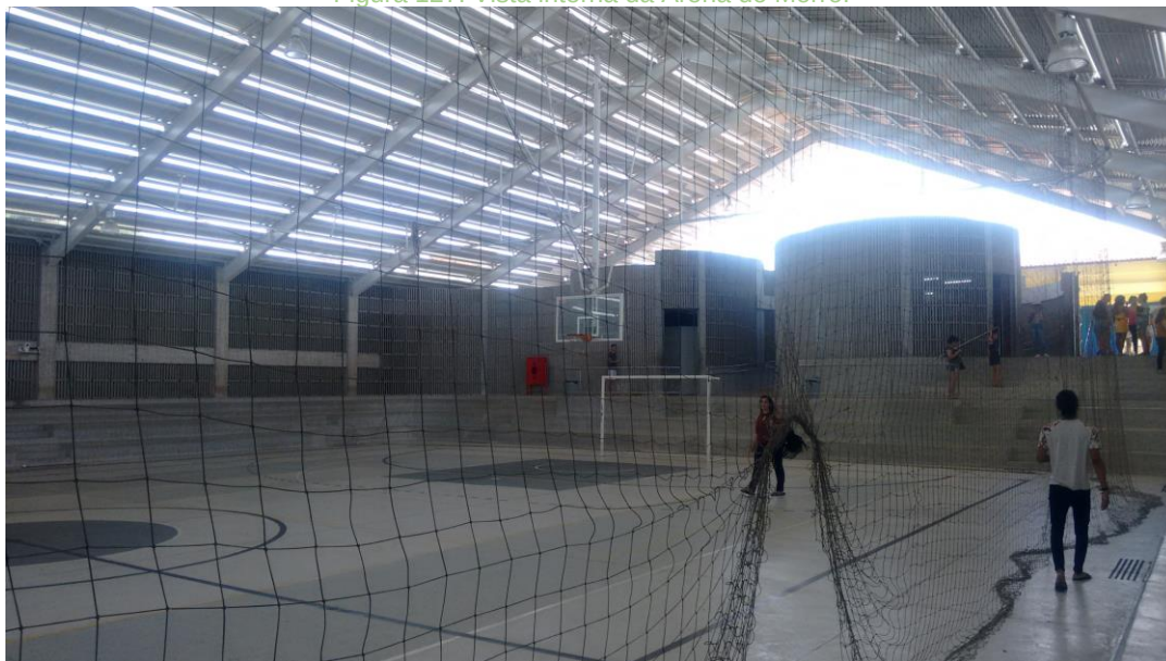
Figura 127: Vista interna da Arena do Morro.
