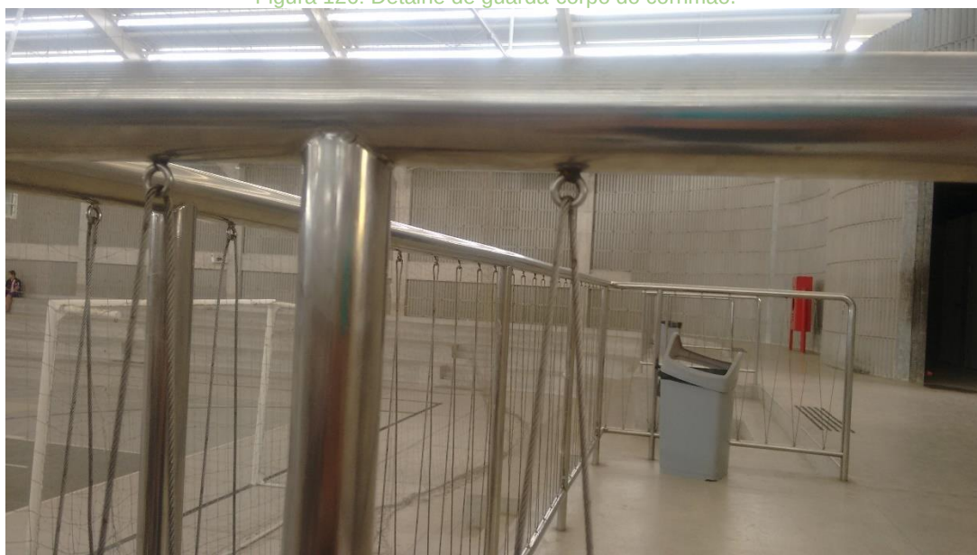
Figura 126: Detalhe de guarda-corpo do corrimão.
