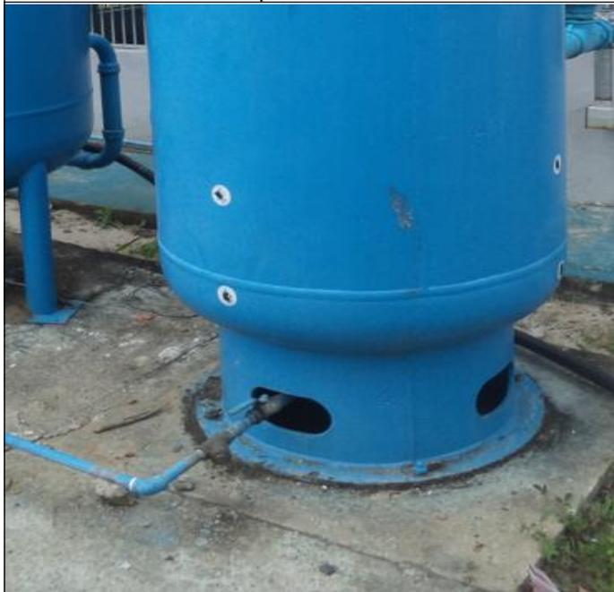
Foto 06 – Medição de espessura de chapa do costado por ultrassom.
