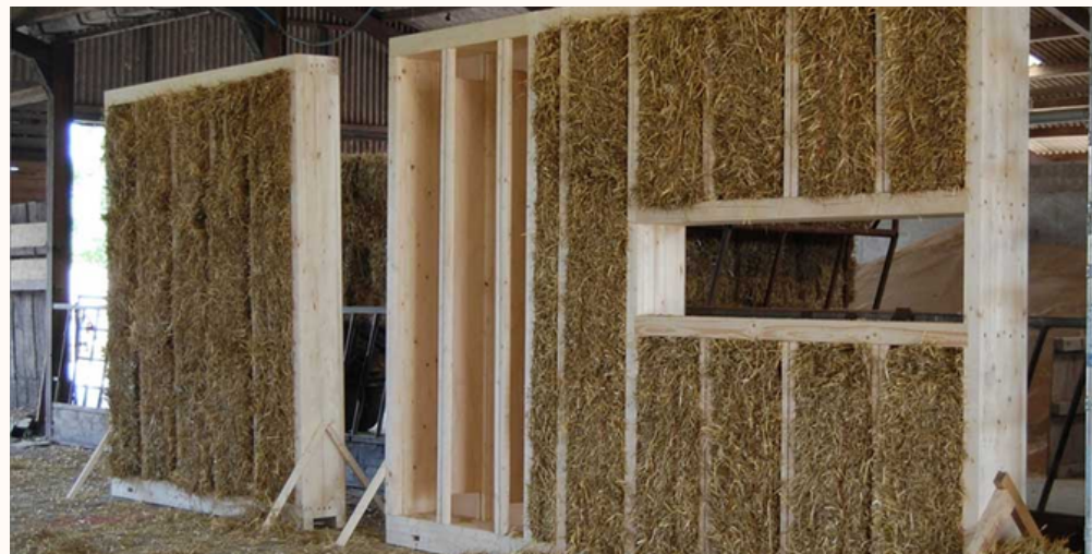
Figura 11: Parades revestidas internamente com feno
