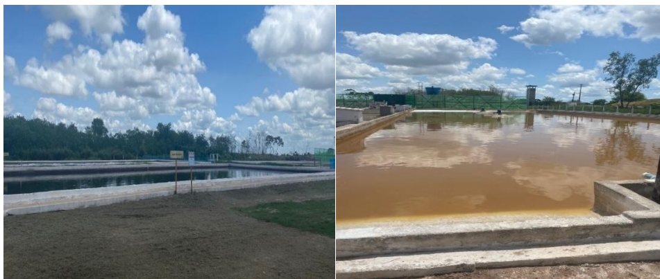
Figura 18 - Estação de tratamento de efluente (ETE) do Aterro Sanitário Metropolitano de João Pessoa
