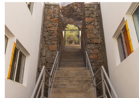
Figura 52. Pedra basáltica usada na estrutura da escada. Esquadrias de alumínio
