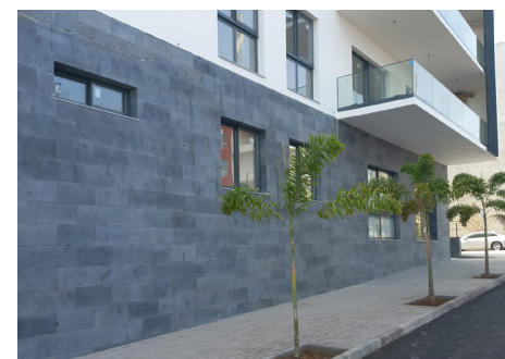
Figura 51. Pedra basáltica utilizada como revestimento na fachada de edificação na Cidade da Praia
