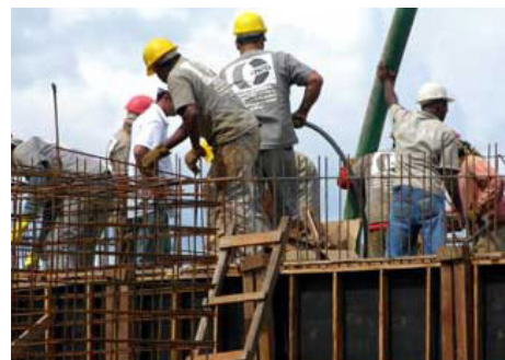
Figura 50. Trabalhadores da construção civil executando o betão/concreto armado
