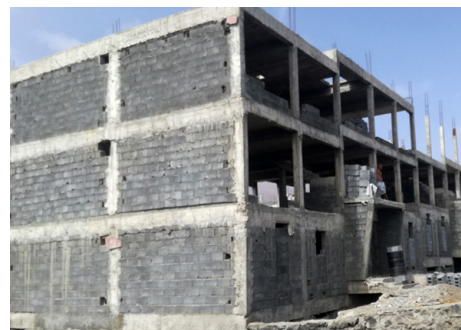
Figura 49. Construção em alvenaria de bloco de cimento, na Cidade da Praia
