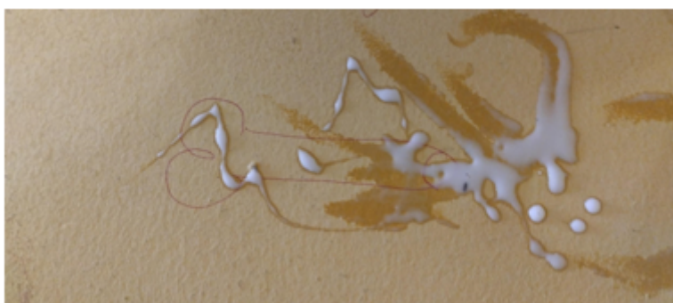
Imagens 42 - Registro da parede da escola, 2023
