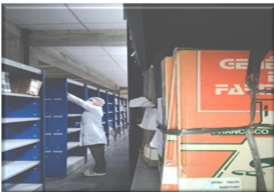
Figura 12 – Início das atividades no prédio sede em reforma
