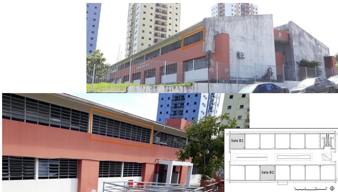
Figura 29 - Escola Municipal Leonel Brizola (escola B)
