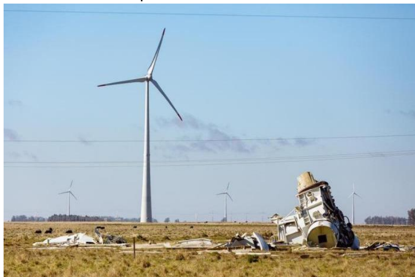
Figura 12 - Parte de estrutura de aerogerador caída na área rural do município da Fronteira Oeste/RS
