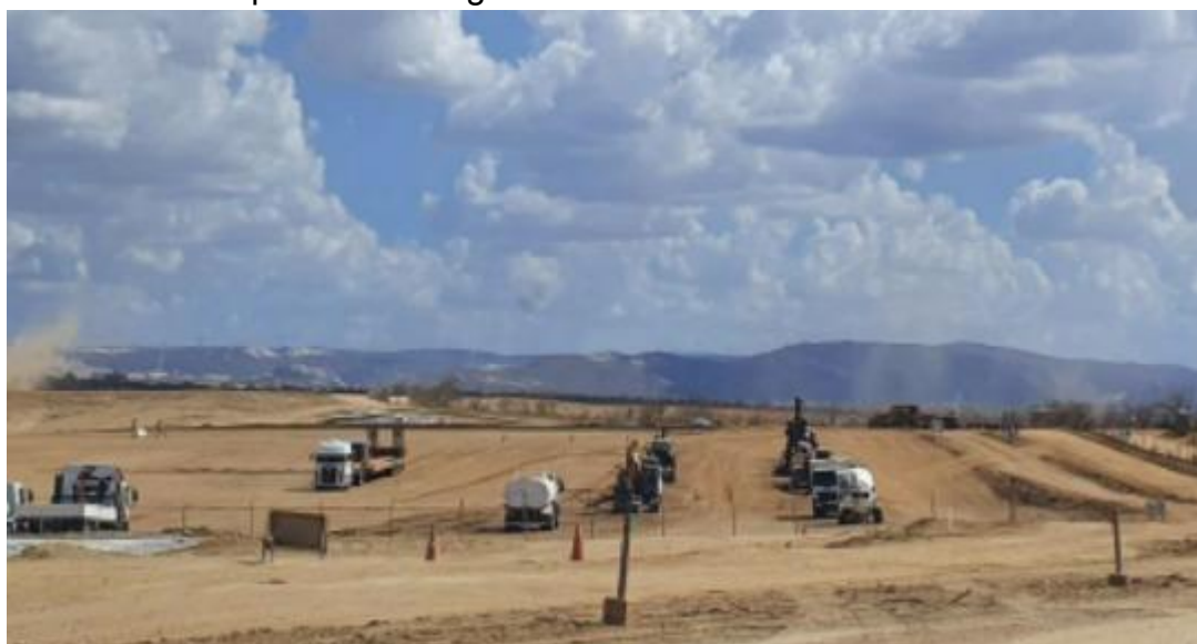
Figura 4 - Canteiro de obras de construção das futuras instalações do complexo de energia solar em Santa Luzia-PB.
