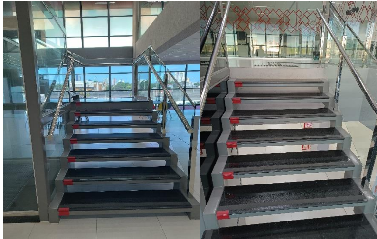
Figura 9 – Escadas para acesso ao segundo pavimento da biblioteca
