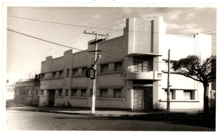
Fotografia 4 – Antigo prédio da Ação Católica sendo reformado para a FAFIC (1969)
