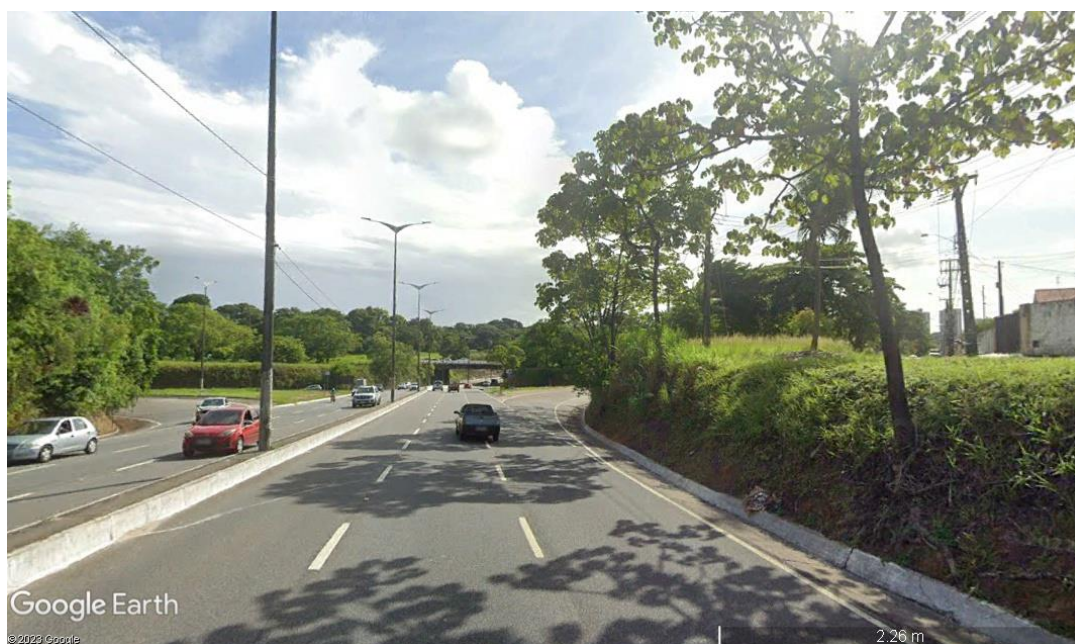
Figura 36: Trecho da Avenida Dom Pedro II no Castelo Branco.
