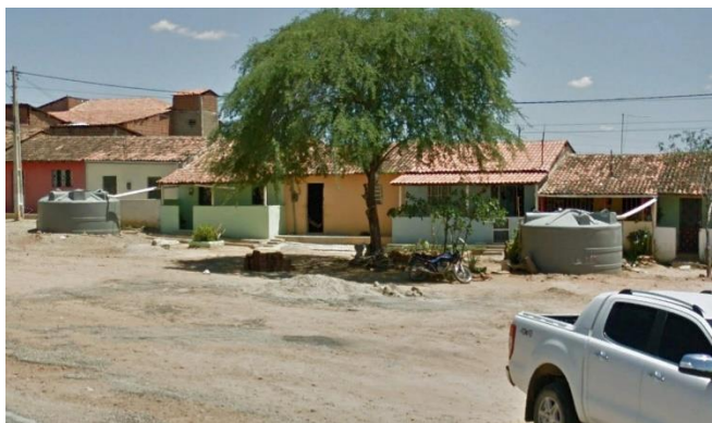
Figura 10. Cisternas de polietileno do Água Para Todos na comunidade Pernambuquinho, município de Sertânia - PE.
