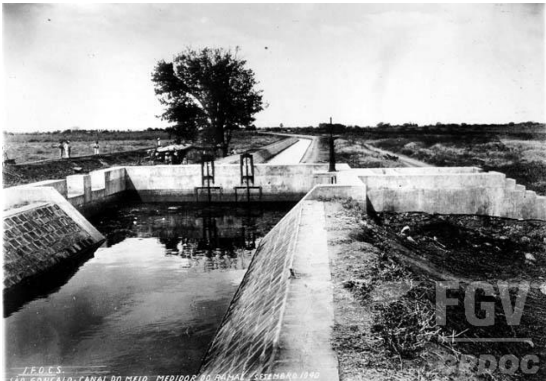
Figura 3. Canal de irrigação em São Gonçalo, estado da Paraíba.
