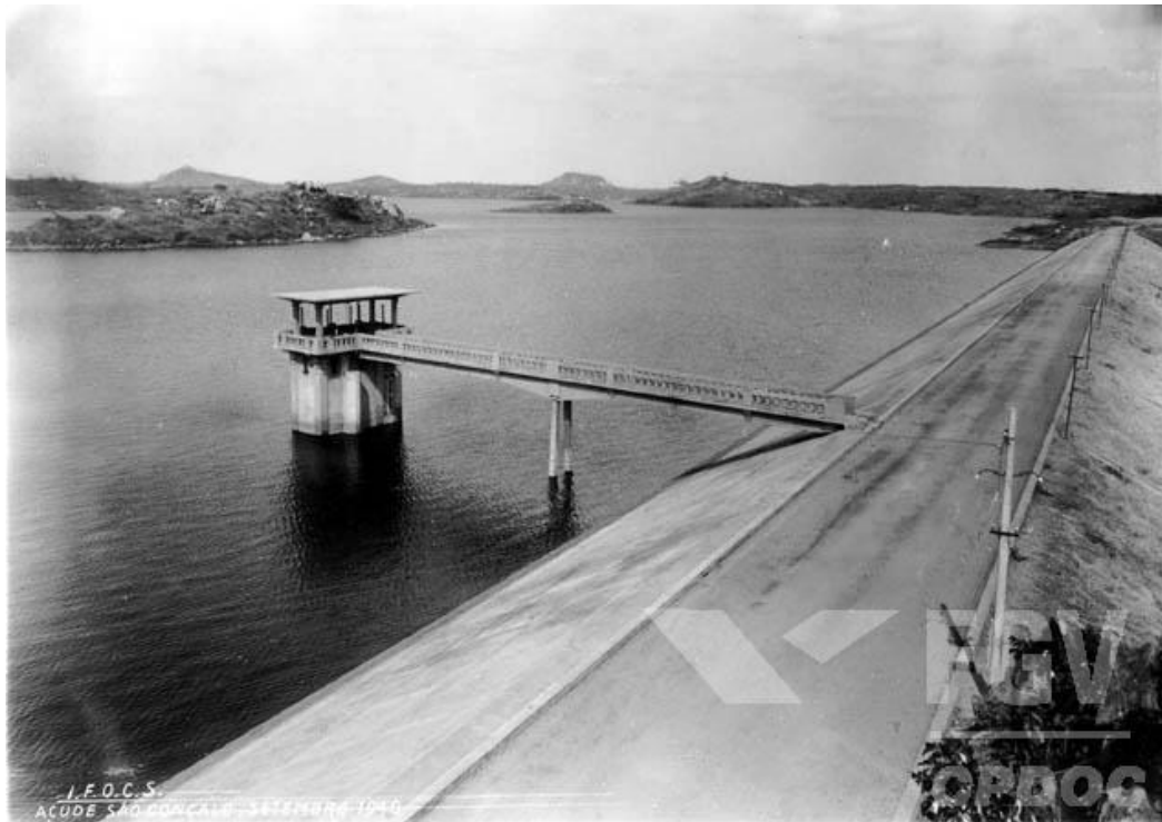
Figura 2. Açude de São Gonçalo, construído pelo DNOCS, município de Sousa-PB.
