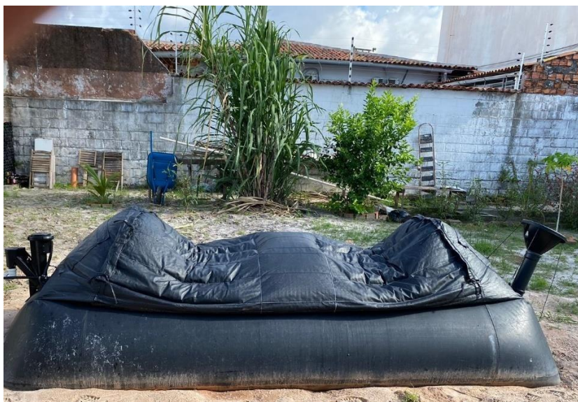
Figura 13. Biodigestor modelo canadense utilizado no Restaurante A Fonte: Autora (2023)
