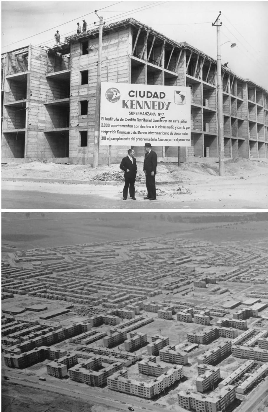
**Figura 66 e 67** - Execução e implantação do conjunto *Ciudad Kennedy*. A obra foi planejada para ser o maior conjunto habitacional da época, abrigando 10.000 moradias, sendo 5.893 autoconstruídas. Além das habitações, o plano previa a criação de superquadras com avenidas arborizadas equipadas de comércios, igrejas, escolas, cinemas, postos de saúde e diversos outros equipamentos que possibilitassem um “morar moderno” a partir da criação de unidades de vizinhança.
