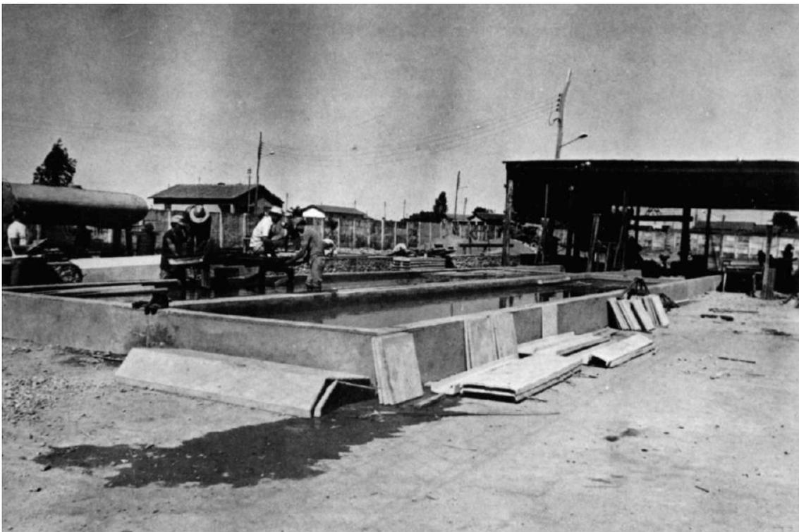
**Figura 97** - Fábrica de componentes de argamassa armada em Abadiânia, Goiás. A fábrica produziu elementos construtivos que foram aplicados na construção de pontes e escolas na zona rural do município, executados com mão de obra popular. Na ocasião, Lelé elaborou um manual ilustrado que guiava a montagem dos elementos in loco. Fonte: Lima (1984).
