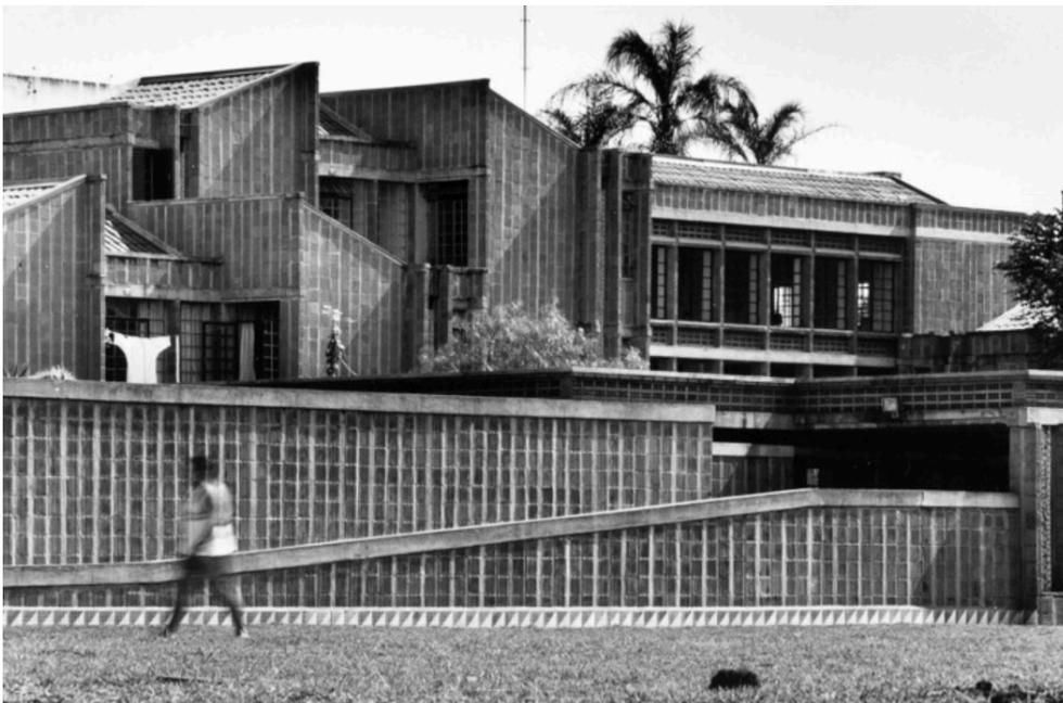
**Figura 81** - Moradia estudantil da UNICAMP. A obra, de autoria de Joan Villà construída com o sistema modular de painéis cerâmicos, inclui amplas residências compartilhadas pelos estudantes. A implantação das unidades ocorreu de forma a viabilizar uma gama de espaços livres de diversas escalas como parques, ruas para pedestres e pátios comunitários.
