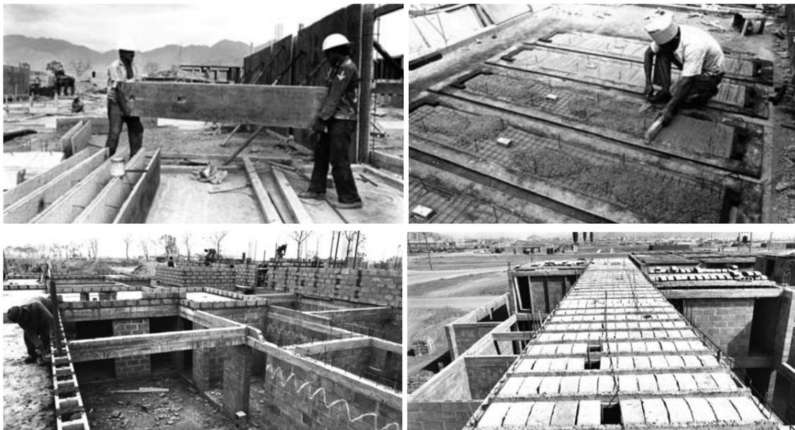
**Figura 95** - Usina e Canteiro do bairro PREVI. Na tipologias foram utilizados elementos como painéis e vigas feitas de ferro e cimento, pré-fabricados em moldes confeccionados na Usina. Os componentes foram utilizados na construção de paredes e lajes das tipologias habitacionais.
