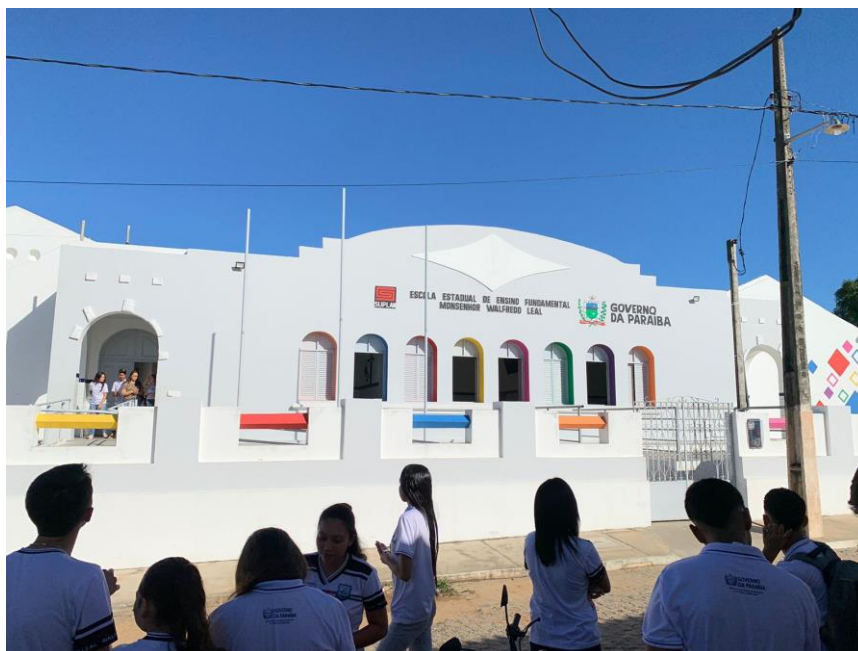
Vista da fachada da Escola Monsenhor Walfredo Leal – Ano: 2023
