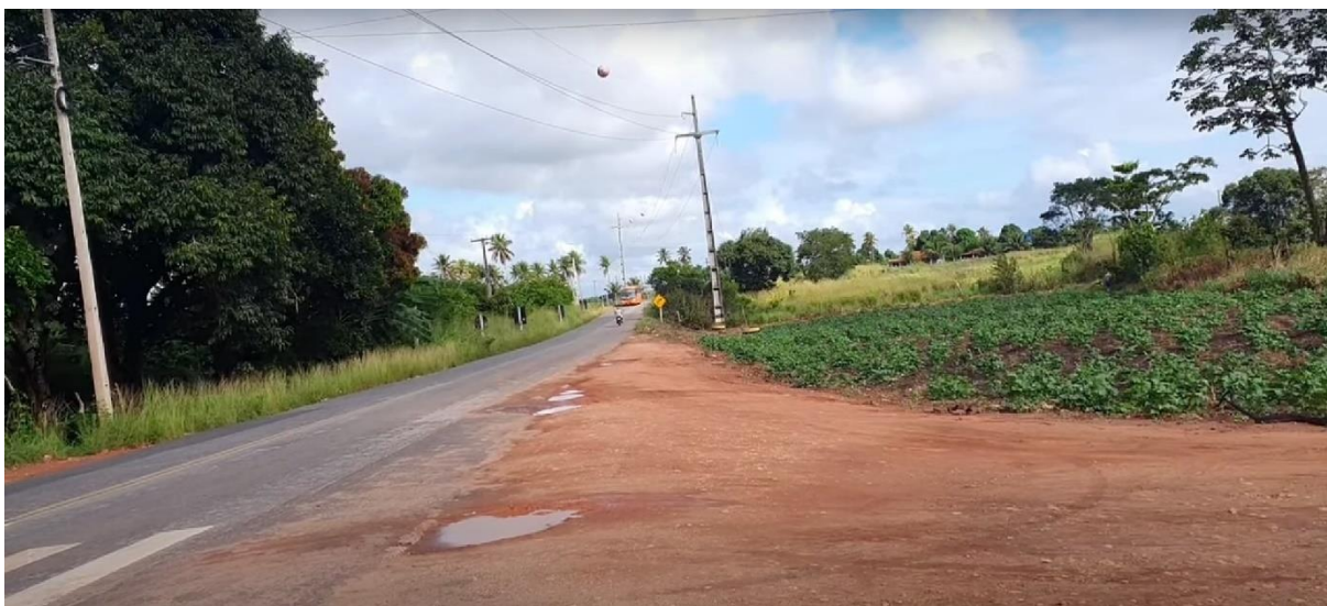
Imagem 03 - Entrada para o Assentamento Rainha dos Anjos na PB-004
