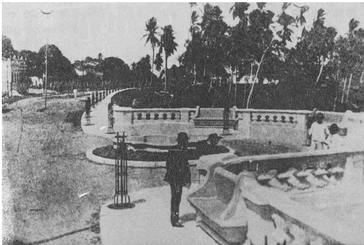
Figura 3 - Vista parcial da Rua das Trincheiras no bairro de Jaguaribe.
