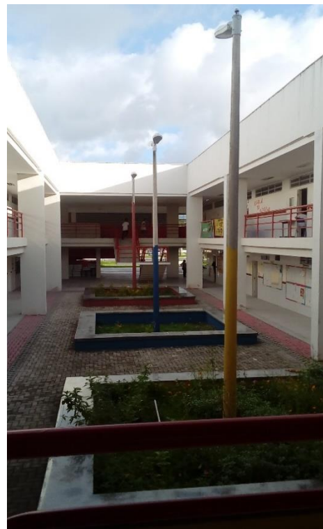
Foto 17: no térreo ficam as salas do setor administrativo e laboratórios e no primeiro andar as salas de aula.
