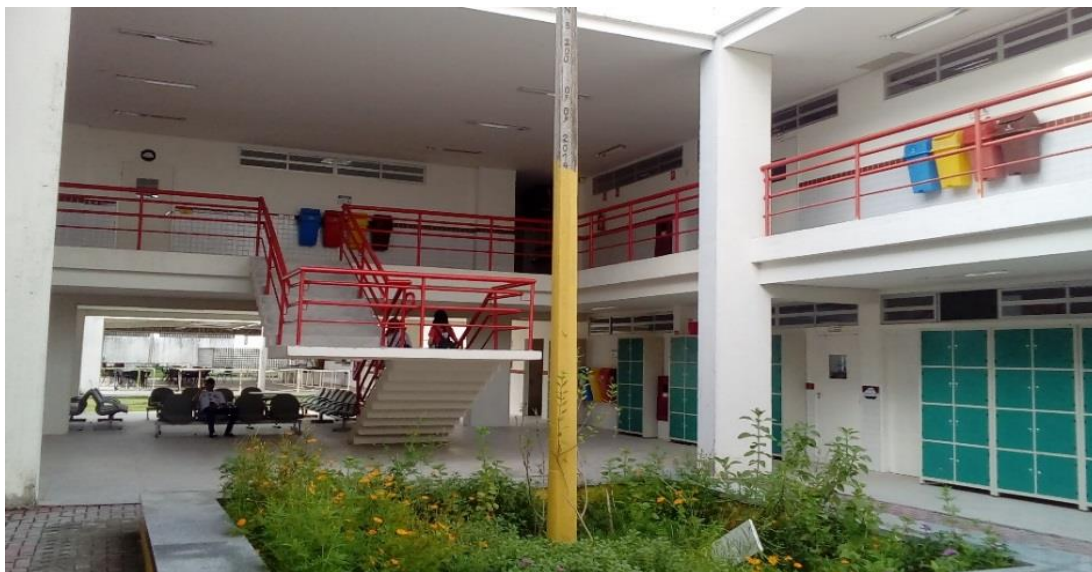
Foto 14: pátio interno da escola que dá acesso as salas de aula e laboratórios
