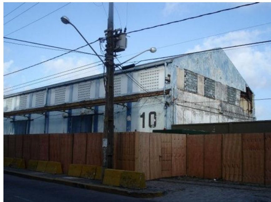
Figura 12- Armazém 10, pouco antes da demolição
