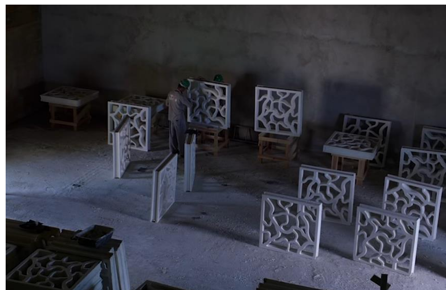
Figura 15- Fabricação do cobogó in loco
