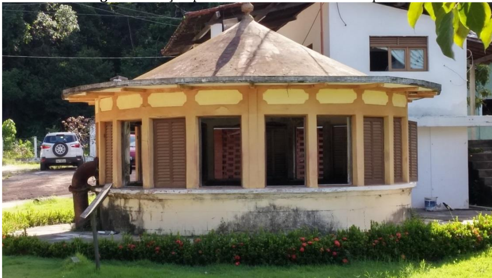
Figura 6 - Poço tipo amazonas do Sistema Buraquinho.
