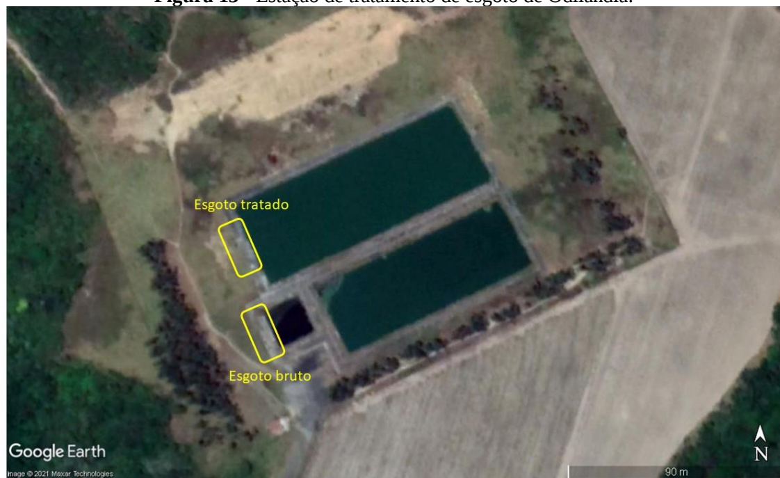
Figura 13 - Estação de tratamento de esgoto de Odilândia.
