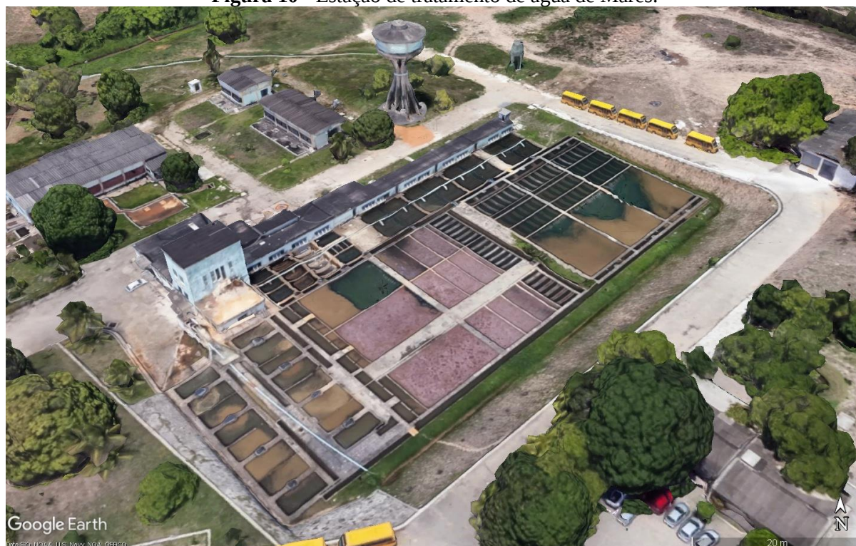
Figura 10 - Estação de tratamento de água de Marés.
