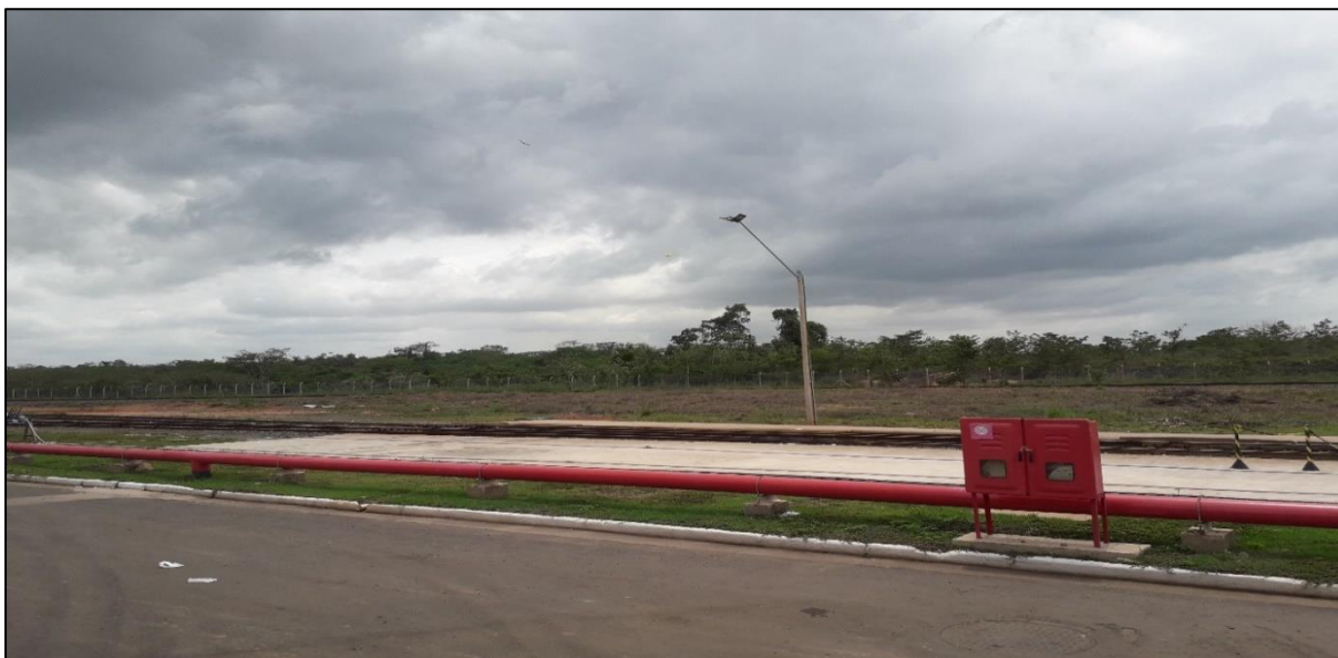
Figura 7 - Linha férrea construída de dentro da indústria Suzano em Imperatriz (MA).
