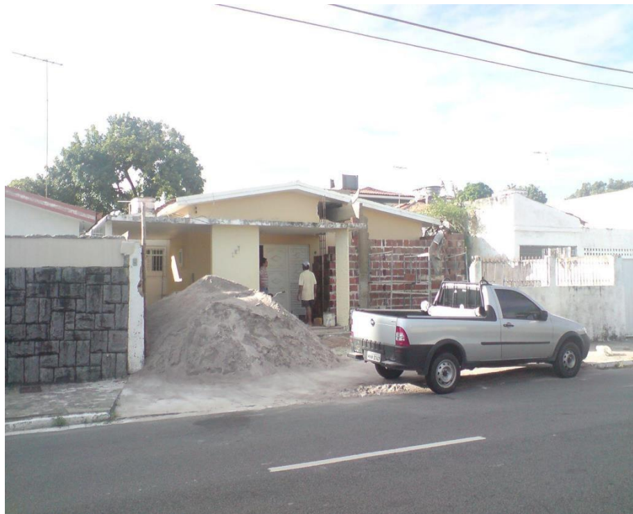
Figura 11: Fachada ampla do ponto físico durante a reforma
