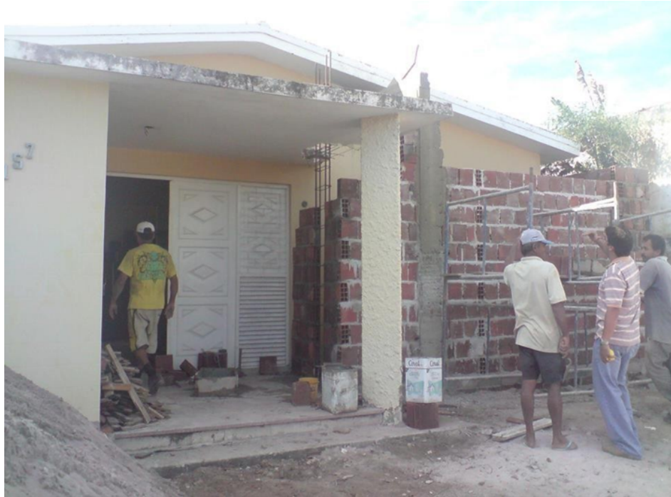
Figura 10: Entrada do ponto físico durante a reforma
