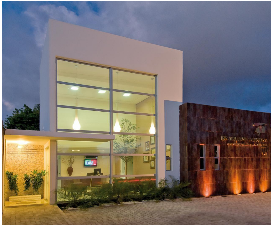
Figura 12: Fachada do ponto físico depois da reforma
