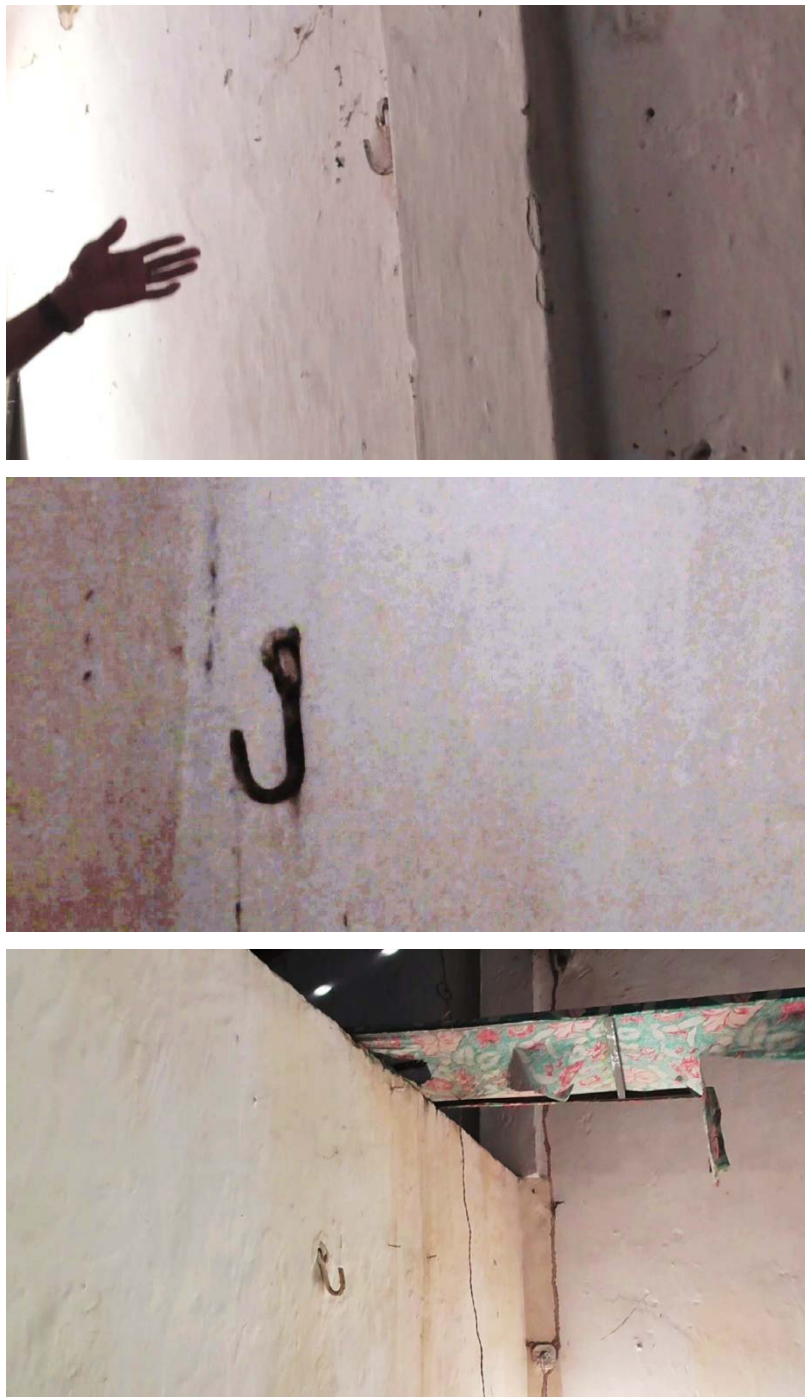
Figura 11 - Ganchos de rede na casa operária
