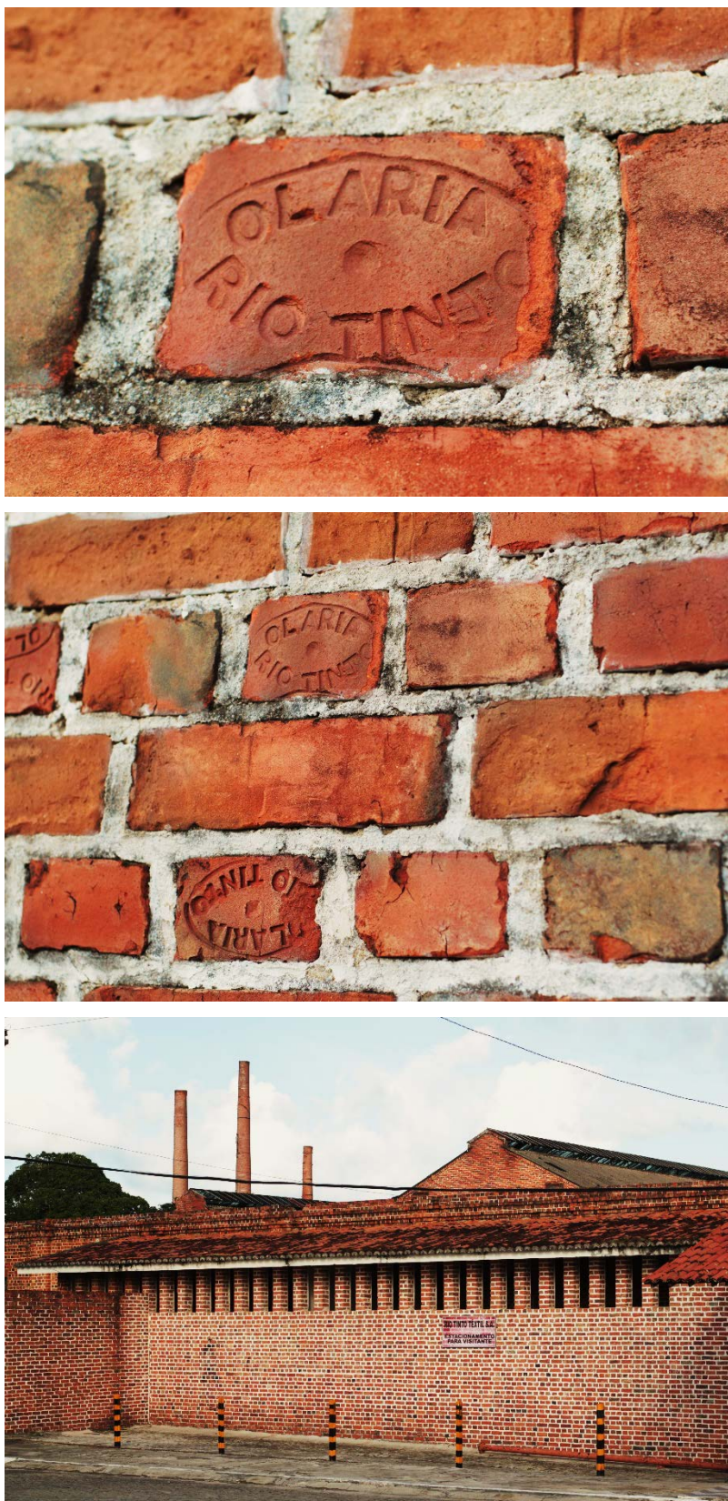
Figura 22 - Tijolos da Olaria Rio Tinto
