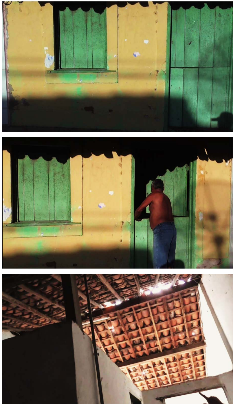
Figura 7 - Fachada e telhado de casa operária original da rua Barão do Triunfo
