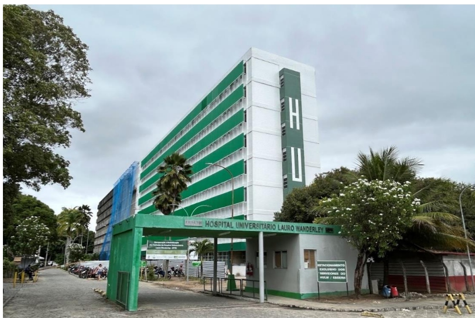
Figura 5 – Estrutura física externa do Hospital Universitário Lauro Wanderley, com destaque para o frontispício, alçado lateral, posto de vigilância e entrada do estacionamento
