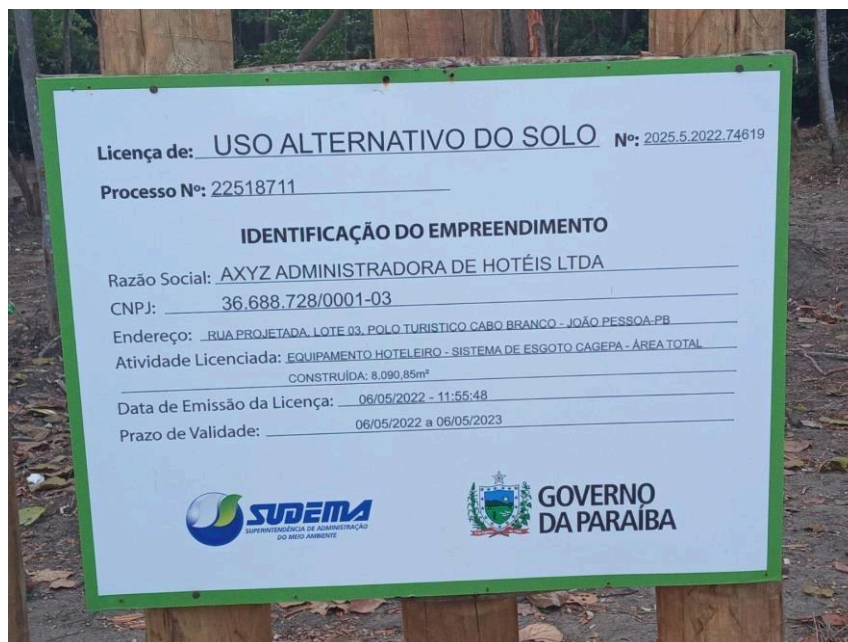
Imagem 11. Obras iniciadas do “Equipamento Hoteleiro” em Jacarapé. Fonte: WhatsApp , Rede Jacarapé. Outubro de 2022.
