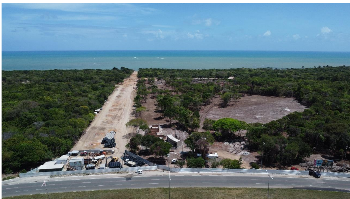
Figura 18 - O Boulevard dos Ipês e o Acquaí Park Resort no início das obras.
