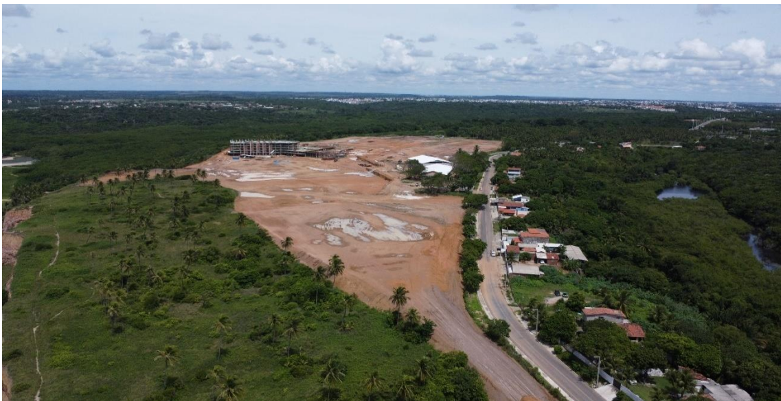
Figura 16 - Área da construção do Resort Tauá e o rio Cuiá
