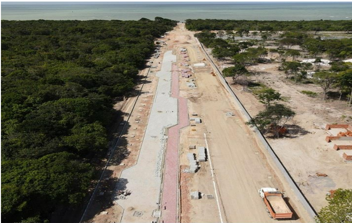
Figura 19 – A construção da avenida do Boulevard dos Ipês.
