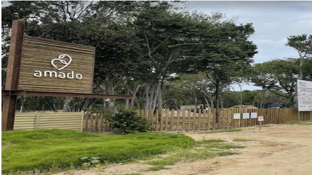
Figura 20 – A obra do Amado Bio & Spa Hotel.
