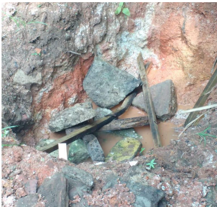
Figura 14 – Vala escavada e primeira camada de metralhas e galhos de madeira
