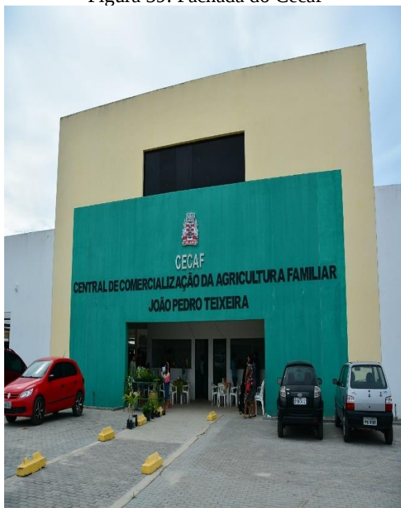
Figura 39: Fachada do Cecaf
