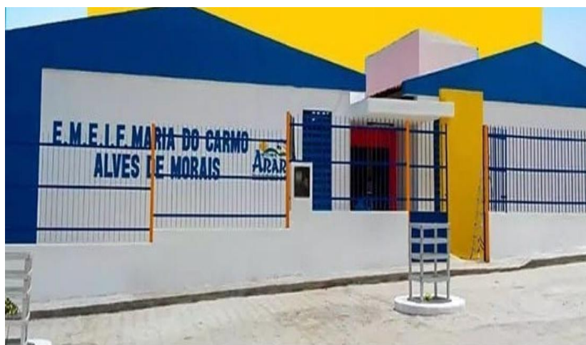
IMAGENS 1, 2 E 3 – Fachada e espaços físicos da Escola Municipal de Ensino Fundamental Maria do Carmo Alves de Moraes.
