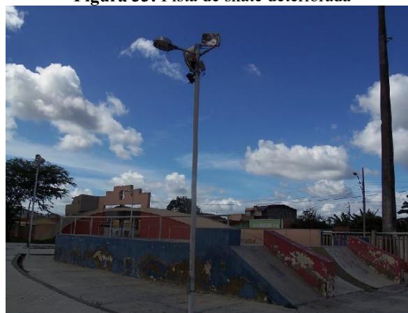
Figura 33: Pista de skate deteriorada
