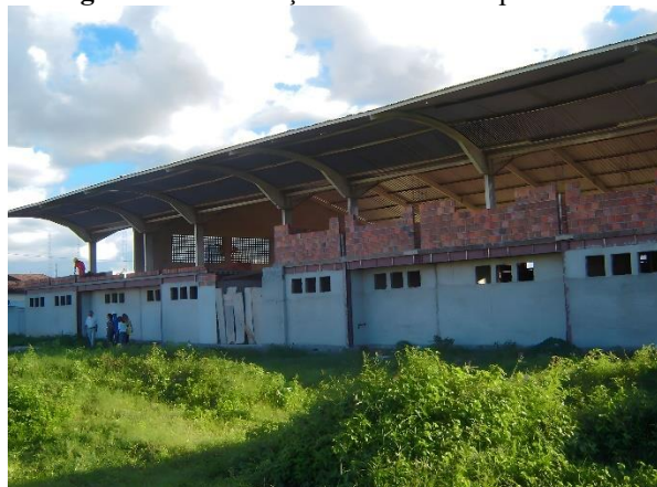
Figura 20: Construção do Ginásio Esportivo
