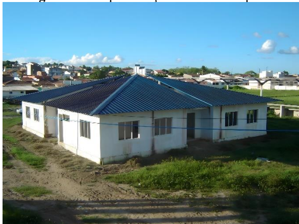
Figura 19: Requalificação da Vila Olímpica
