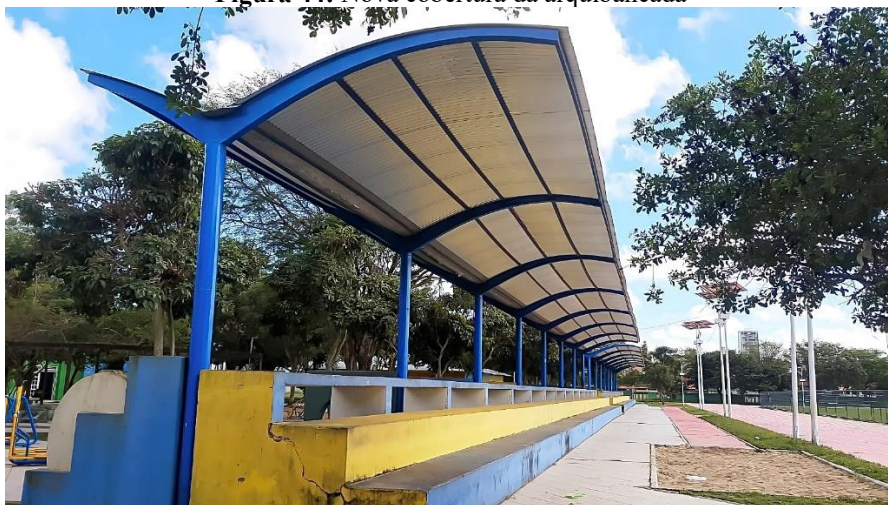
Figura 44: Nova cobertura da arquibancada
