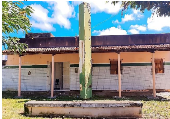
Figura 39: Cozinha comunitária desativada
