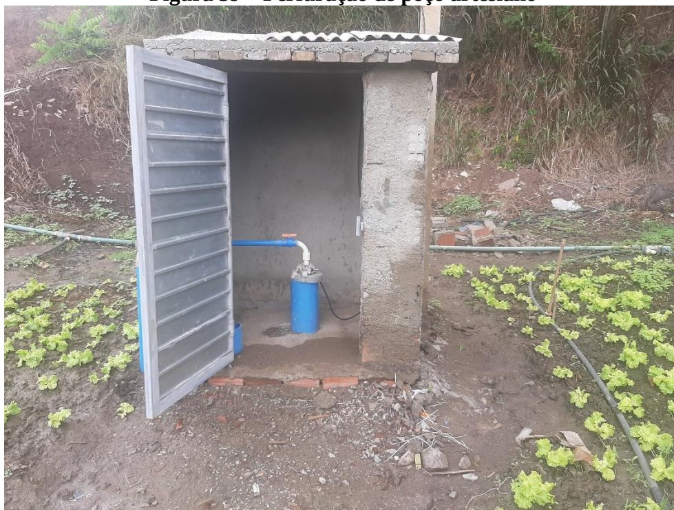
Figura 39 – Perfuração de poço artesiano
