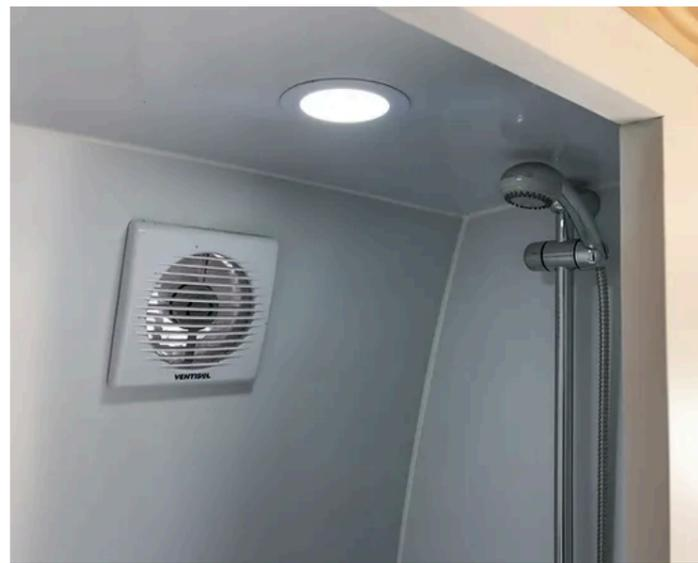
**Figura 27** - Detalhe do exaustor e da ducha portátil.
