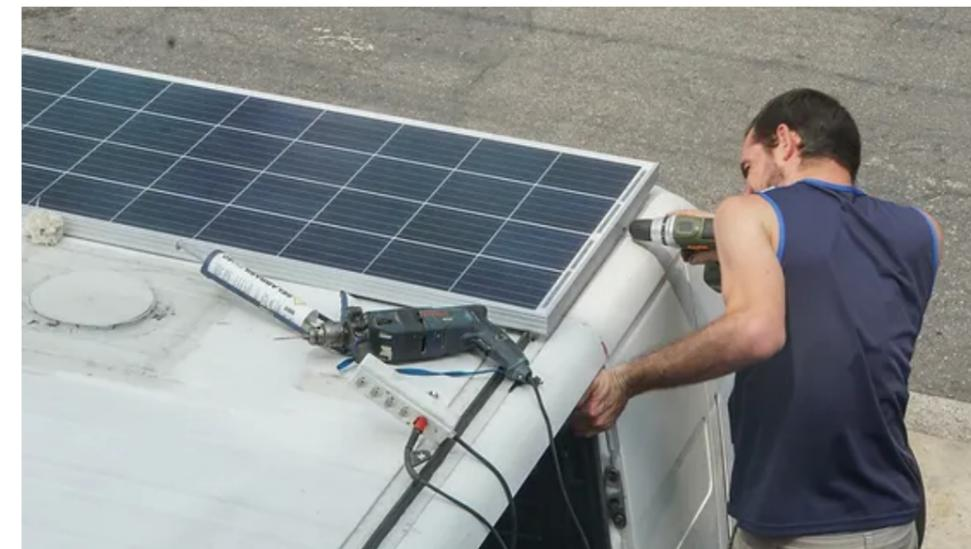
Figura 30 - Instalação dos painéis solares.
