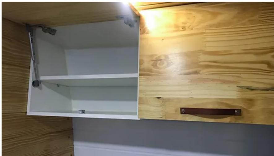
**Figura 34 - Sistema de abertura basculante nos armários.**
