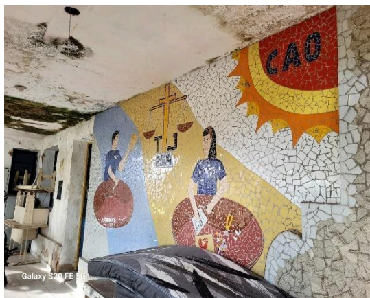
Figura 03. Antigo Prédio CAO – Centro de Atividades Ocupacionais
