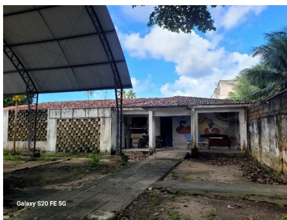
Figura 02. Antigo Prédio CAO – Centro de Atividades Ocupacionais
