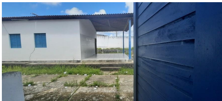
Figura 19 - Vista do Exterior de uma das Aberturas na David Trindade
