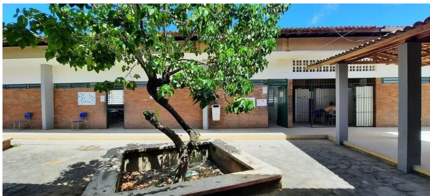
Figura 25 - Vista do Exterior de uma das Aberturas na Dom Helder
