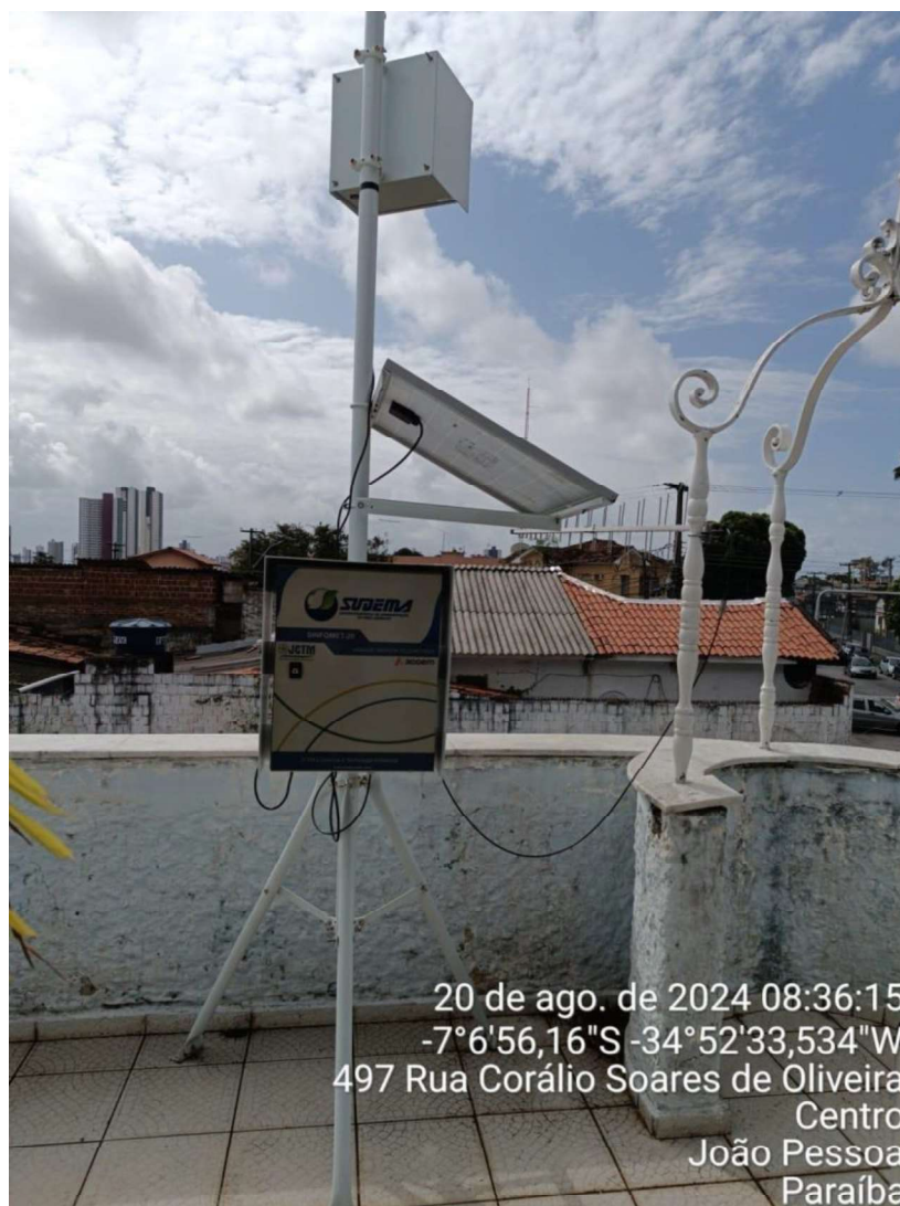
Figura 6 – Estação de monitoramento de qualidade do ar, instalada na sede da SUDEMA, em João Pessoa.
