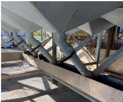
Calha de purga de lodo decantador lamelar (13)
