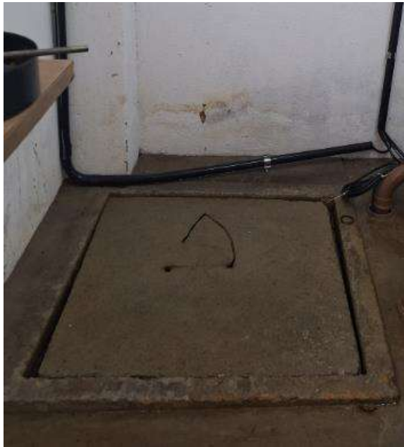
Figura 7 - Reservatório enterrado 1 (cisterna) da UPA Cruz das Armas
