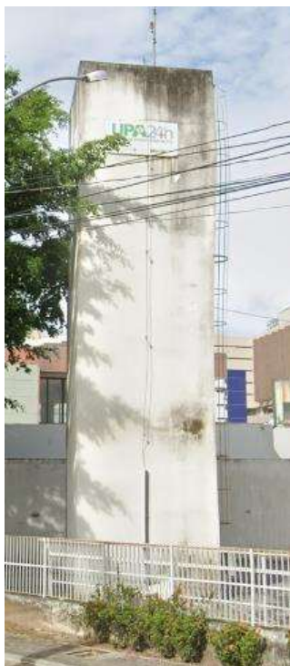
Figura 13 - Estrutura que abriga a caixa d'água da UPA Oceania
