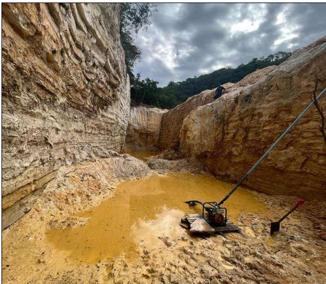
Figura 35: Mina de caulim alagada por ter atingido lençol freático, Junco do Seridó (PB) - 2023
