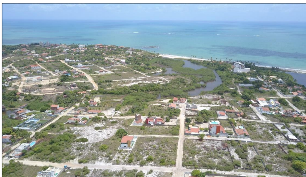
Figura 69 - Ocupação urbana acompanhando a planície de inundação da foz do riacho Bucatu,
