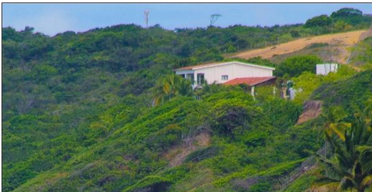
Figura 65 - Edificações no topo de falésias inativas dentro dos limites de APP em Praia Bela
