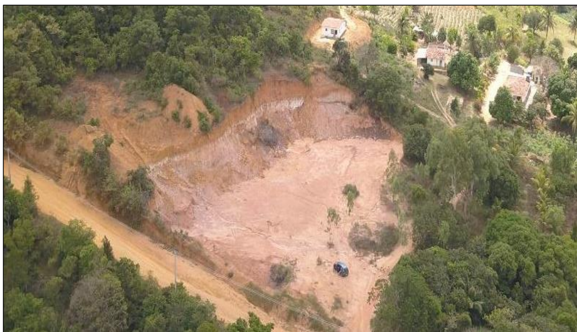
Figura 70 - Enclave de escavação para aterro em vertente de platô tabular, com remoção da terra e exposição do latossolo, na beira da estrada, contrastando com vegetação de encosta nativa e monoculturas diversas, no interior da APA
