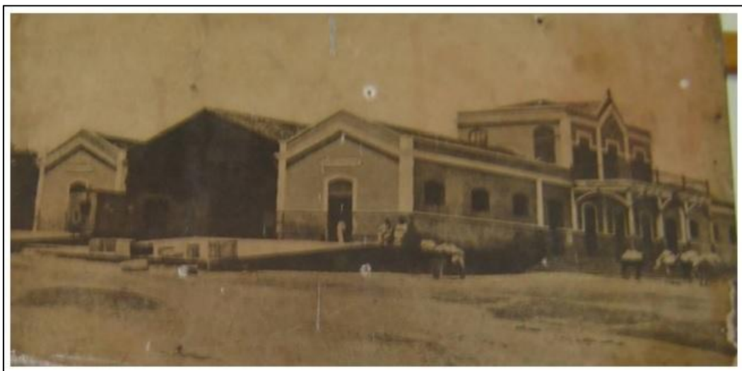
Figura 9 Antiga Estação Ferroviária de Garanhuns
