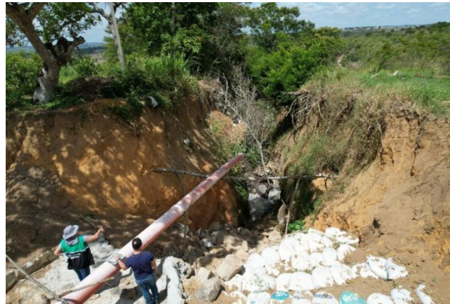
Figura 36 Tubulação vinda da zona urbana sendo despejada em área periurbana de Garanhuns.
