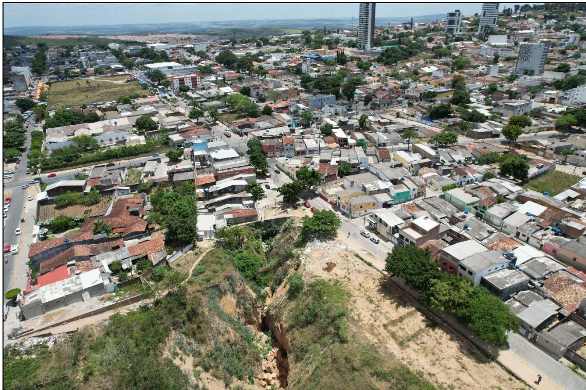
Figura 23 Despejo de materiais oriundos da construção civil nas encostas na voçoroca da Liberdade
