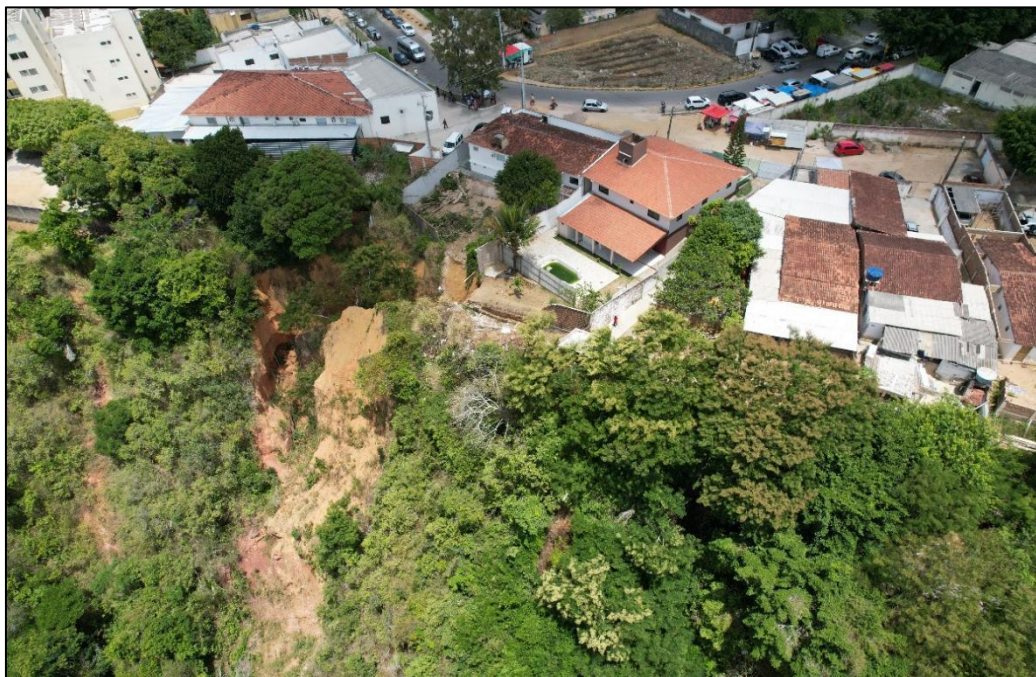
Figura 22 Grande processo erosivo na Avenida Senador Paulo Guerra – Garanhuns - PE.
