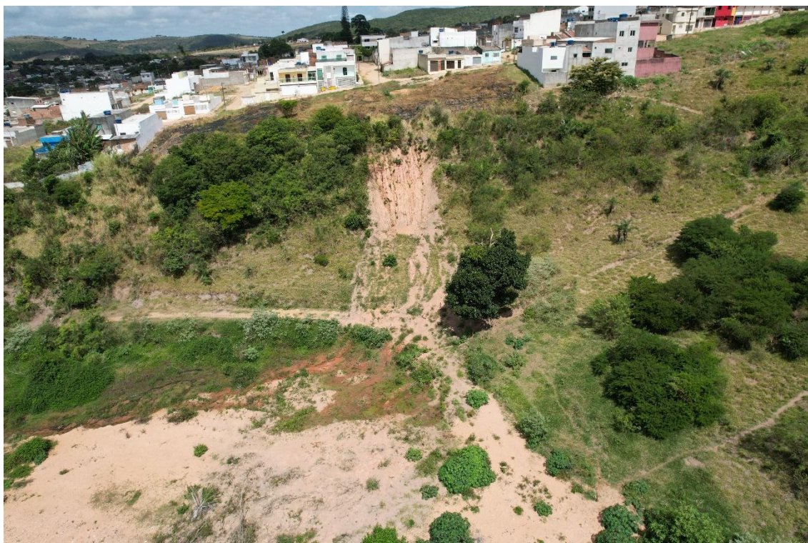
Figura 49 Área exposta a erosão na cidade de Garanhuns – PE
