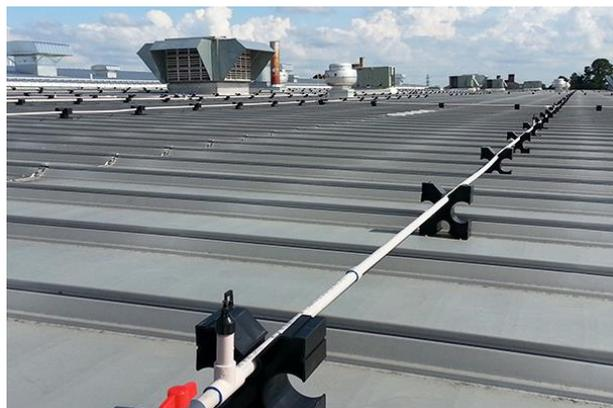
Figura 2.2 - Sistema de aspersão em cobertura. Fonte: PATTERSON VENTILATION (2021).
