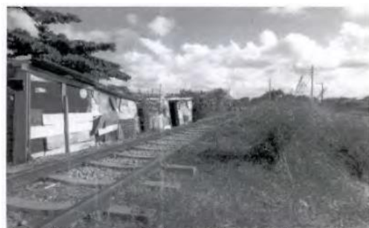
Ilustração 7: Barracos construídos à menos de 5 metros dos trilhos, grande risco de acidente. Observe a presença de moradores, inclusive crianças em cima dos trilhos.
