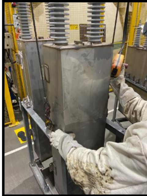
Figura 22 - Retirada do capacitor do carrinho
