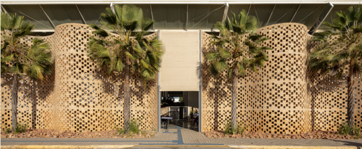
figura 16 - vista externa da cdo hospital veterinário escola da unileão
