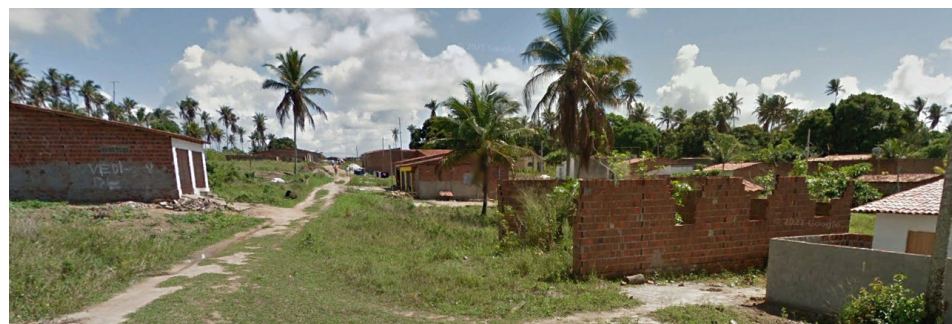
Figura 71: Rua 02 do Setor Residencial 03 Fonte: Google earth, 2023.
