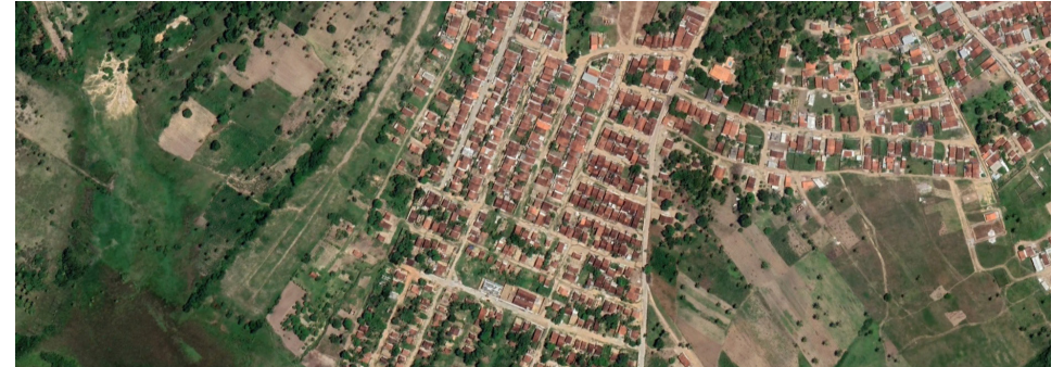
Figura 67: Vista aérea do S. Residencial 02 Fonte: Google earth, 2025.
